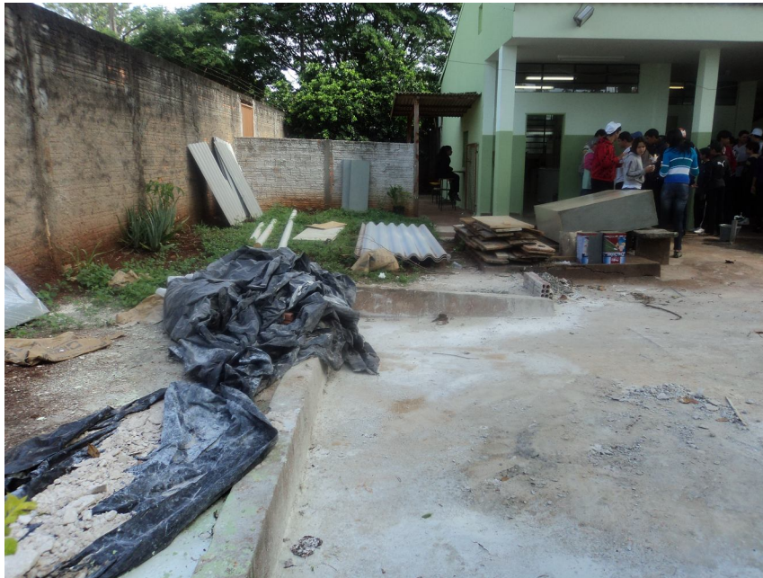
Figura 13: RCC em um canteiro de obras II em Londrina-PR
