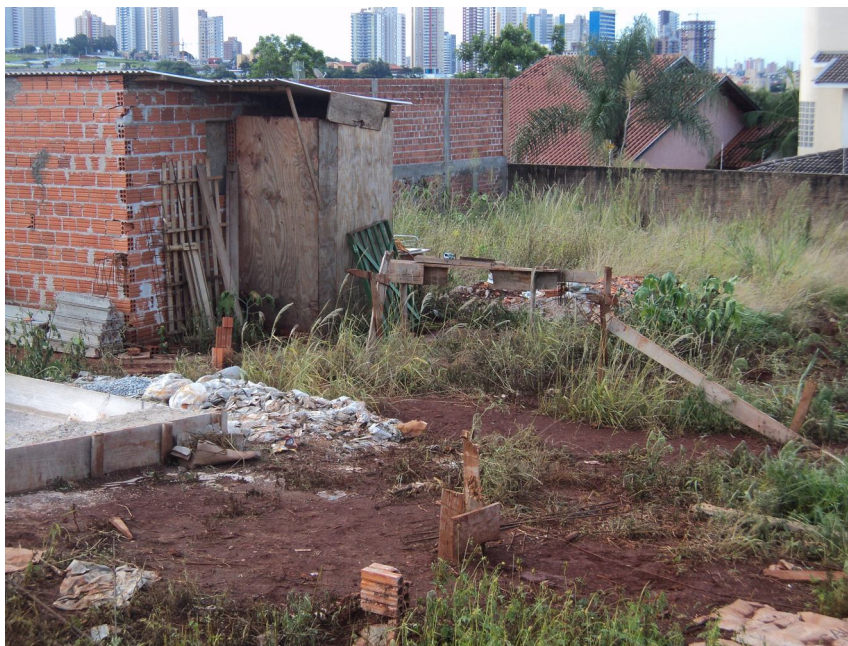
Figura 12: RCC em um canteiro de obras I em Londrina-PR
