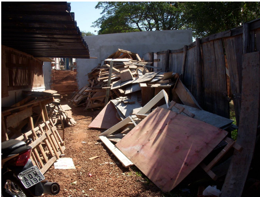
Figura 14: RCC em um canteiro de obras III em Londrina-PR
