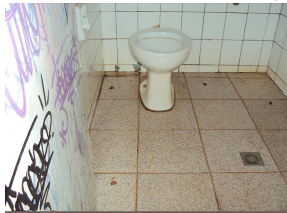
Figura 39: Banheiro dos alunos
