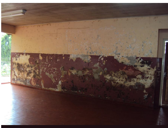
Figura 37: Paredes da circulação
