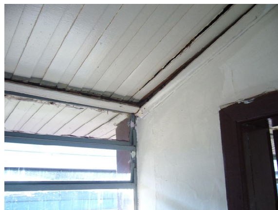
Figura 11: Forro dos banheiros
