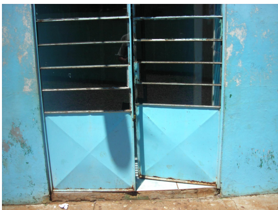
Figura 26: Porta da circulação bloco salas aula
