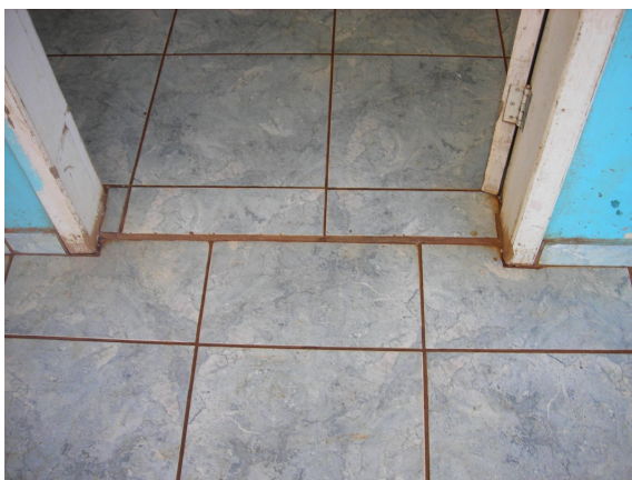
Figura 32: Pisos e portas das salas de aula
