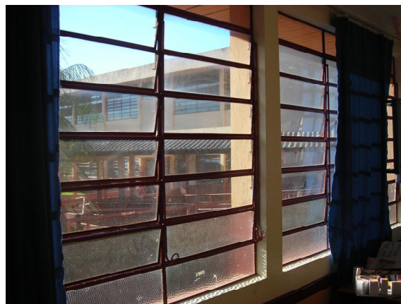
Figura 55: Janelas das salas de aula
