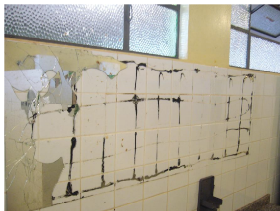
Figura 67: Paredes banheiro masculino
