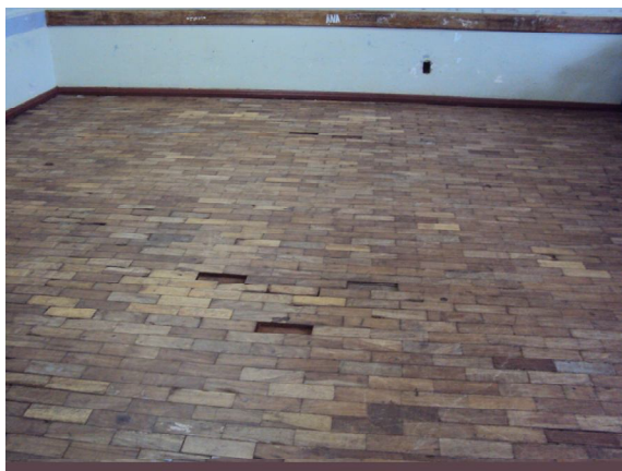
Figura 34: Pisos das salas de aula
