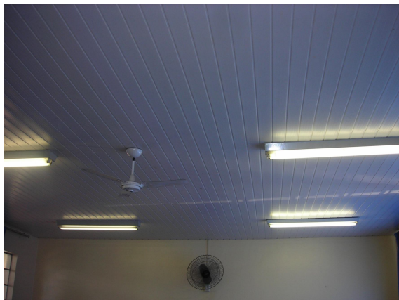
Figura 04: Teto das salas de aula
