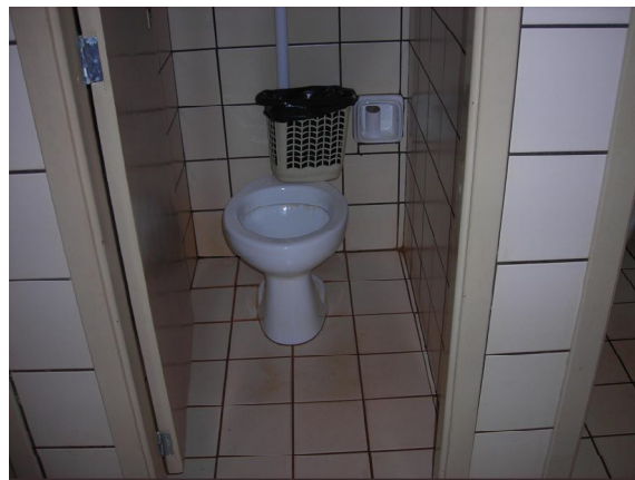
Figura 61: Banheiro dos alunos
