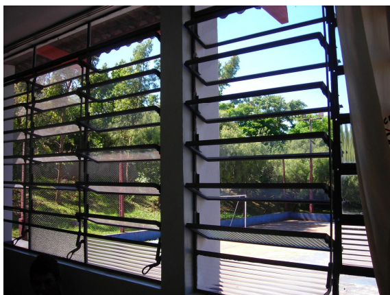
Figura 24: Janelas das salas de aula
