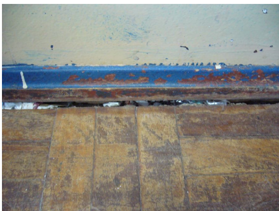
Figura 52: Pisos das salas de aula
