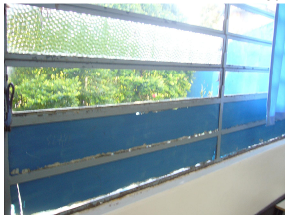
Figura 13: Janelas das salas de aula
