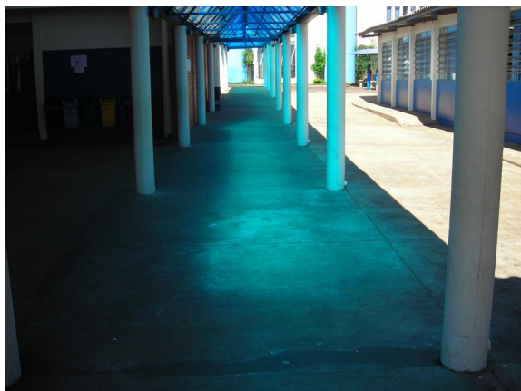
Figura 02: Área de circulação pátio
