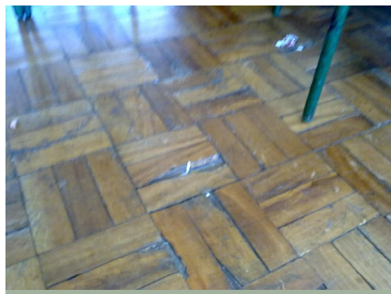
Figura 07: Piso das salas de aula
