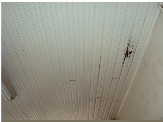
Figura 40: Forro das salas de aula
