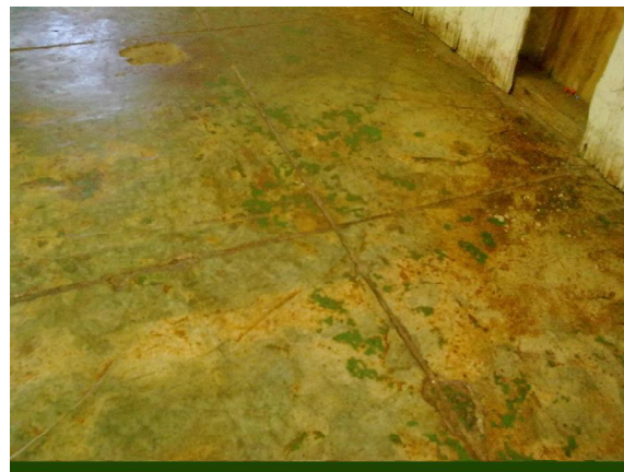
Figura 17: Piso do laboratório de física/química
