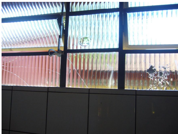
Figura 42: Janelas das salas de aula
