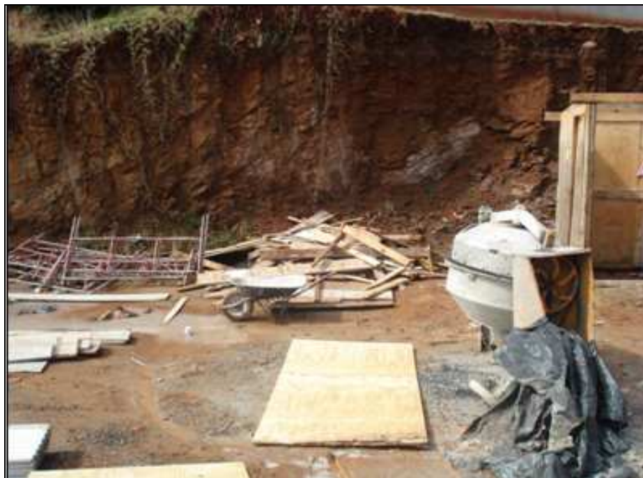
Figura 8: Canteiro de obras - Caso 4 Fonte: Elaboração do Autor, 2010
