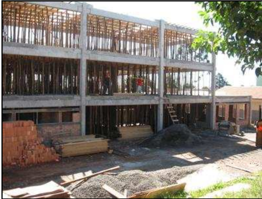
Figura 3: Canteiro de obras – caso 1 Fonte: Elaboração do Autor, 2010
