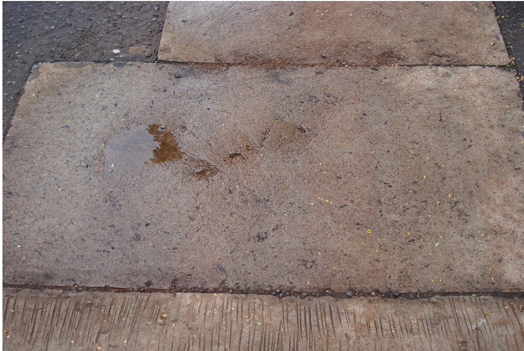
Figura 5: Placa 2 utilizando concreto com adição de raspas de pneu Fonte: KATUTA (2007)
