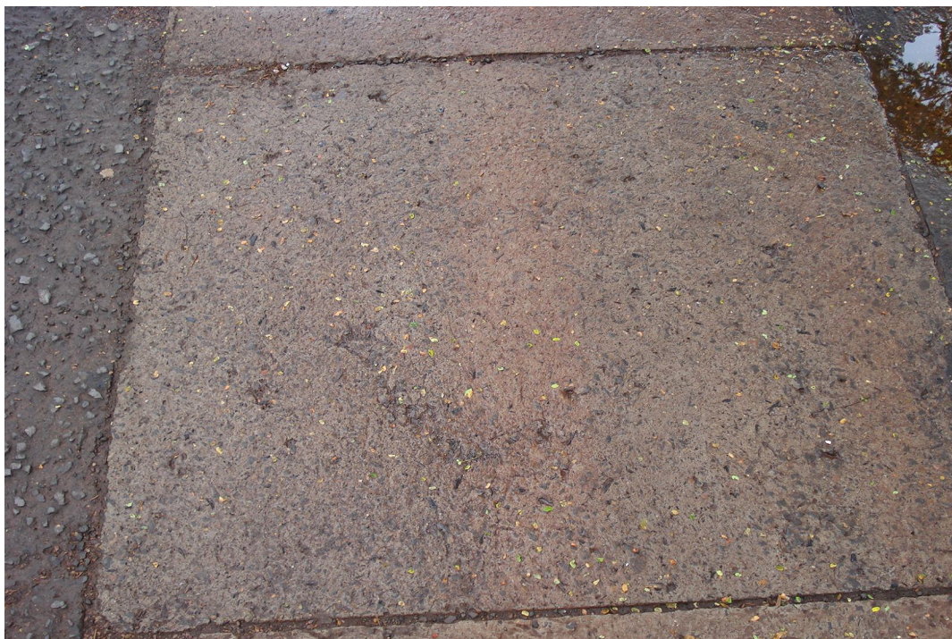
Figura 7: Placa 4 utilizando concreto com 20% de raspas de pneus em relação à massa de areia Fonte: KATUTA (2007)
