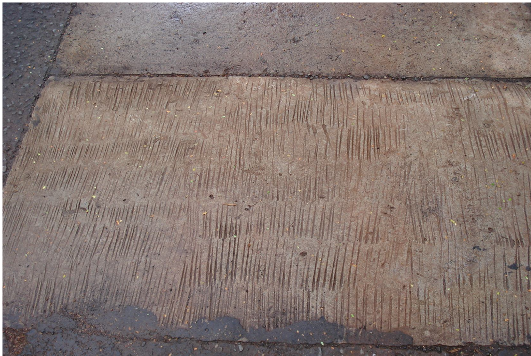
Figura 4: Placa 1 constituída de concreto simples sem adição de agregados especiais Fonte: KATUTA (2007)
