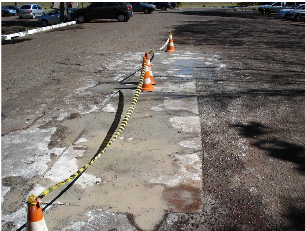
Figura 11: Vista geral da região contígua à zona de reparo Fonte: KATUTA (2007)
