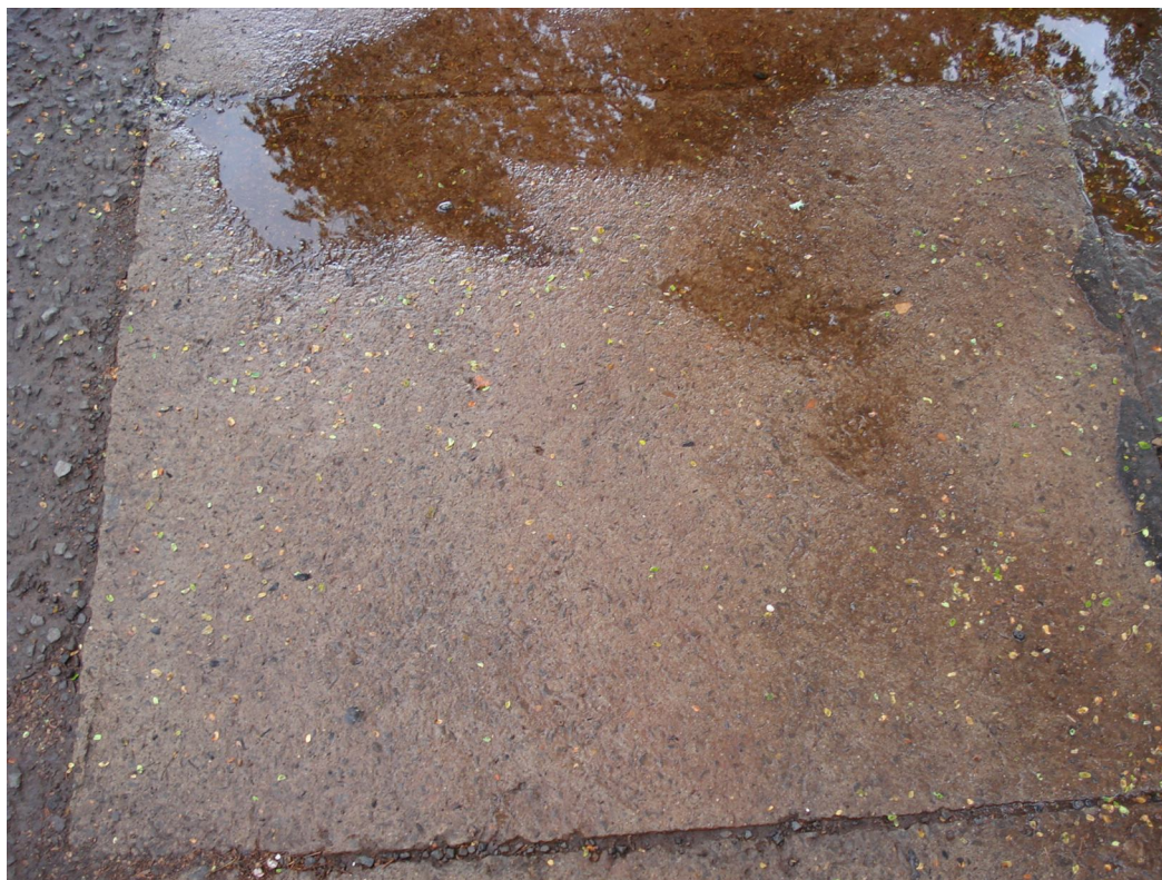
Figura 8: Placa 5 utilizando concreto com 7,5% de raspas de pneus em relação à massa de areia Fonte: KATUTA (2007)
