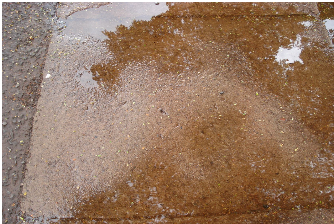
Figura 9: Placa 6 utilizando concreto com adição de 6% de raspas de pneus em relação à massa de areia
