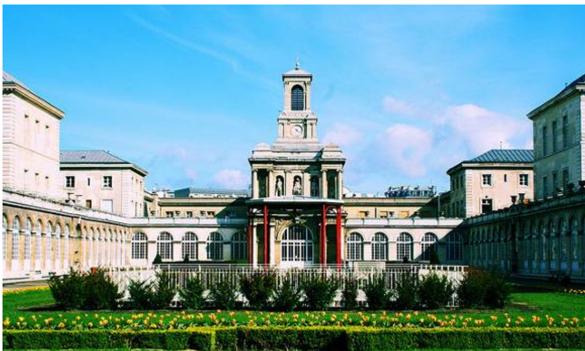
Imagem 7 - Hospital Lariboisière ( fonte: http://www.flickr.com/photos/jbarry5/2911175688/ )
