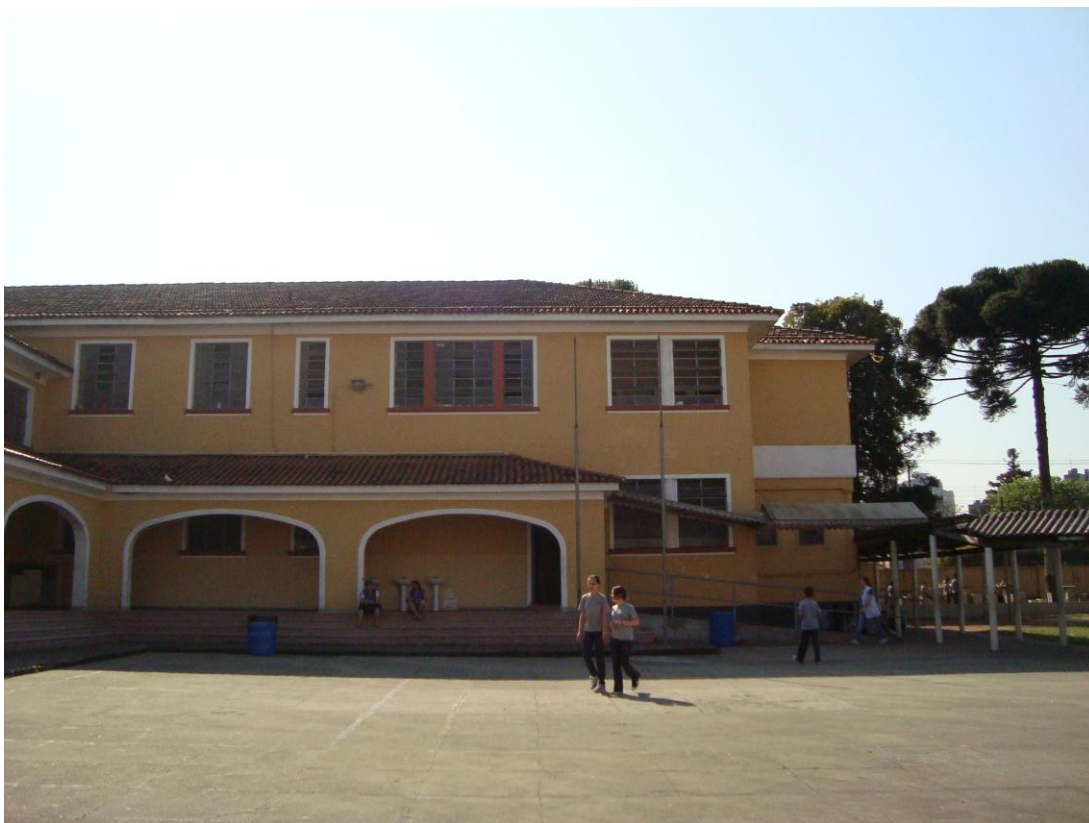
C – Vista do pátio interno 3
