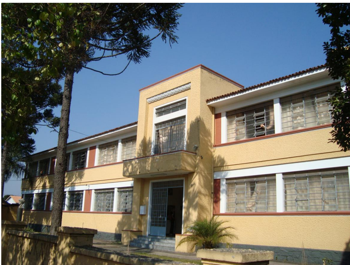
FIGURA 17 - Vista da fachada frontal do colégio
