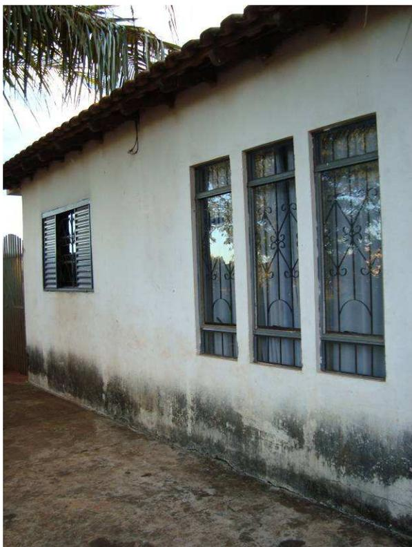
**Figura 6 Casa com infiltração decorrente da umidade do solo**
