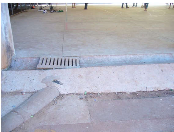
Figura 40: Canaleta da quadra de esportes
