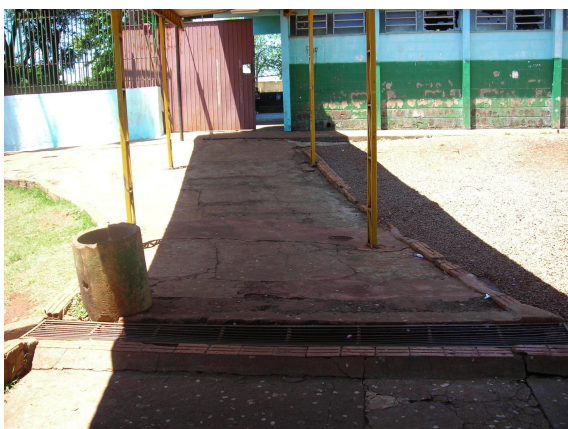
Figura 28: Acesso à quadra de esporte
