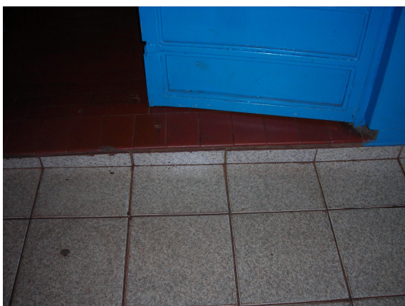
Figura 34: Acesso aos laboratórios
