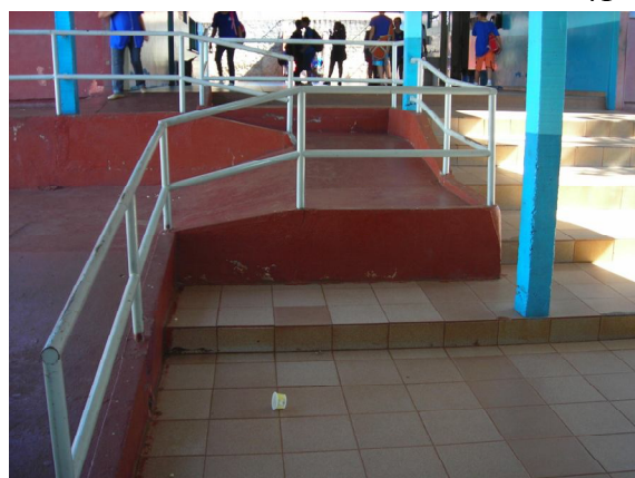
Figura 33: Rampa de acesso entre blocos
