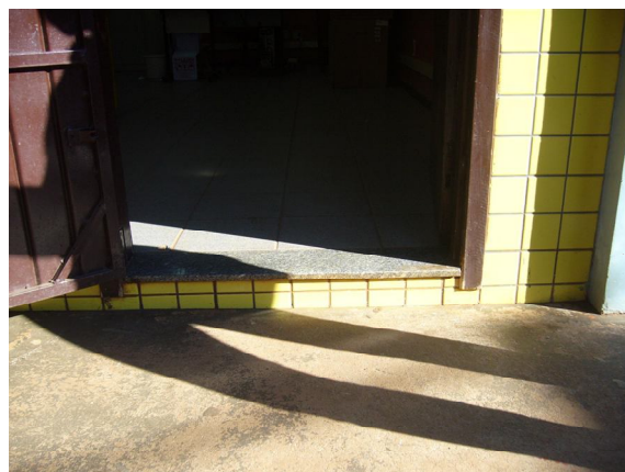
Figura 39: Acesso ao laboratório de informática
