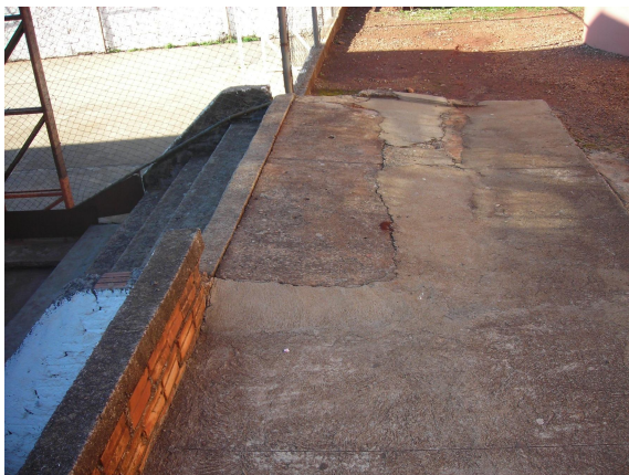
Figura 50: Acesso à quadra de esporte
