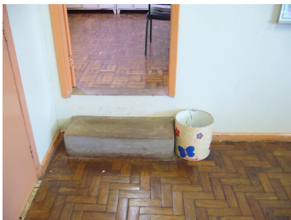
Figura 58: Acesso interno ao lab. informática
