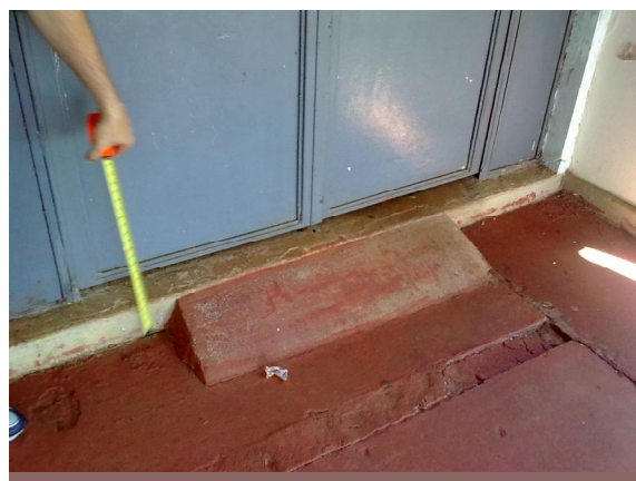
Figura 15: Acesso ao laboratório química/física
