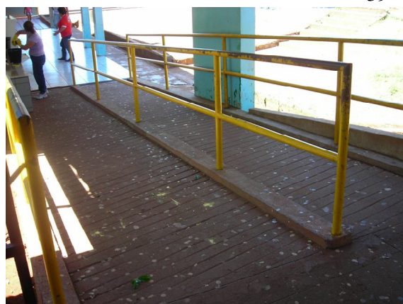
Figura 27: Rampa da circulação
