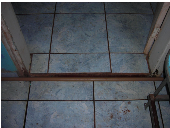
Figura 26: Acesso ao banheiro
