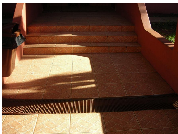
Figura 47: Acesso ao laboratório química/física
