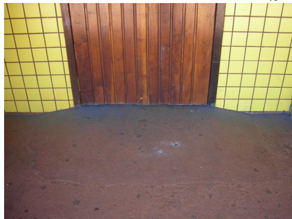
Figura 53: Acesso banheiro PNE
