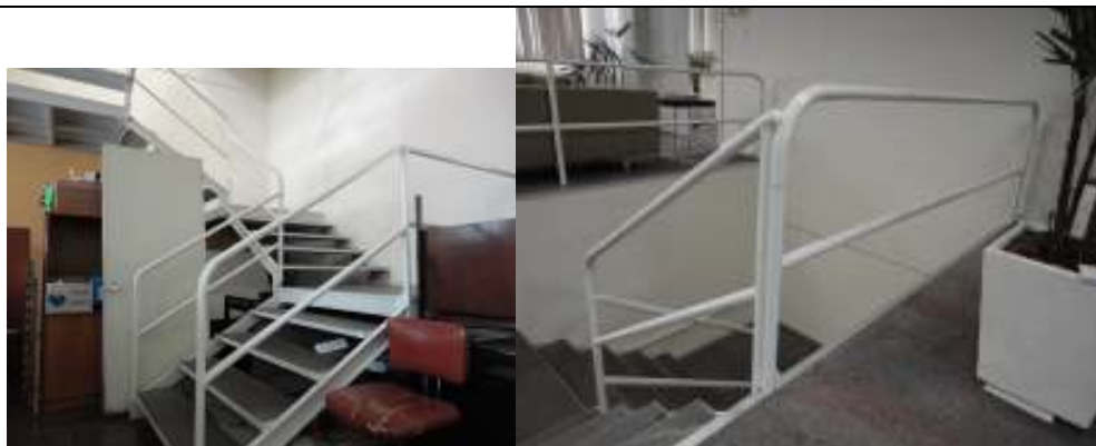
Fotos 29 e 30 – Escada metálica localizada na frente do bloco cuja testada dá para a Praça Carlos Gomes.
