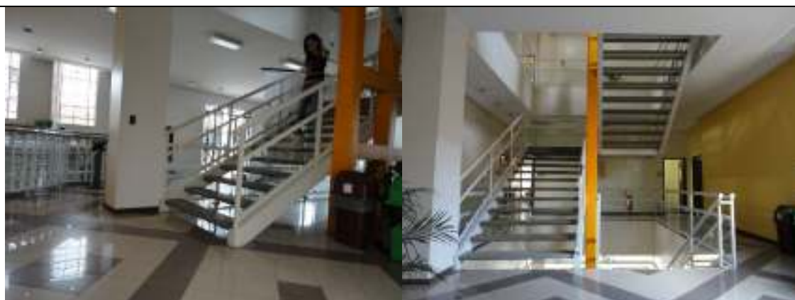
Fotos 23 e 24 – Escada principal, localizada no atrium do pavimento térreo, liga o mesmo pavimento ao segundo.
