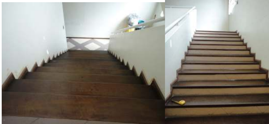
Fotos 27 e 28 – Escada de madeira localizada nos fundos do bloco localizado na esquina das Ruas Pedro Ivo e José Loureiro.
