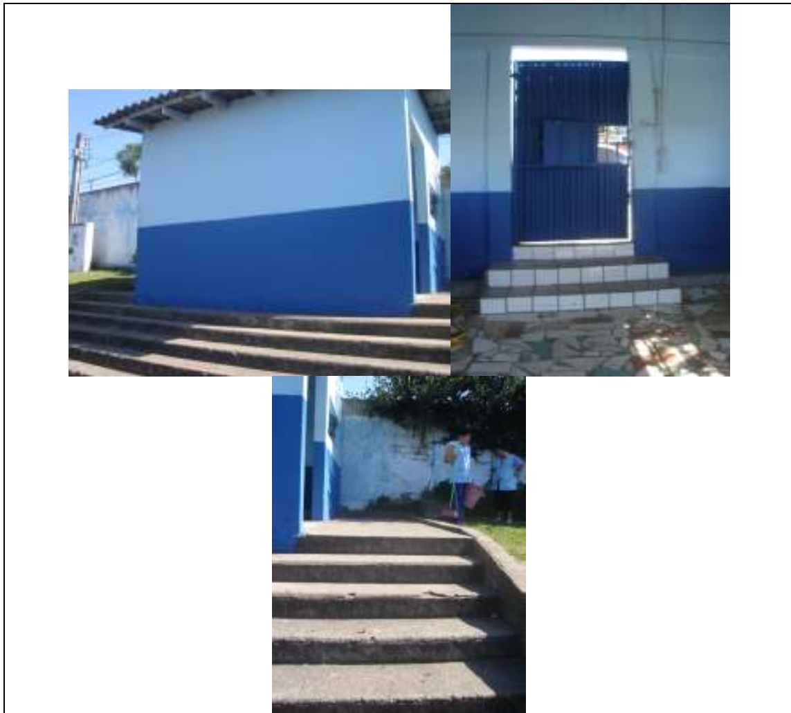
FOTOS 06, 07 e 08– Demolição de paredes e muro de alvenaria, conforme levantamento em anexo. Substituição de portão de acesso principal e execução de portão secundário para acesso à rampa. Demolição e retirada de piso cerâmico para execução de piso cimentado.
