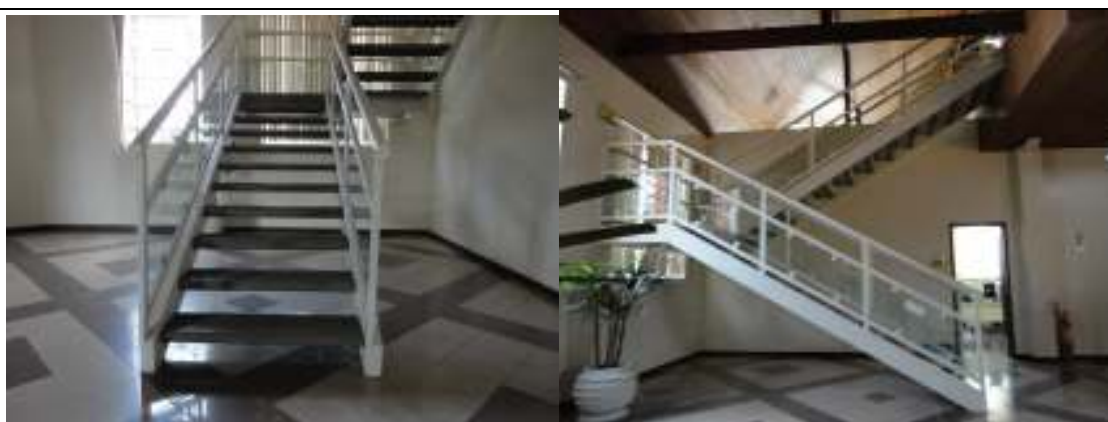
Fotos 25 e 26 – Escada que liga o segundo pavimento ao mezanino. Semelhante a escada principal.
