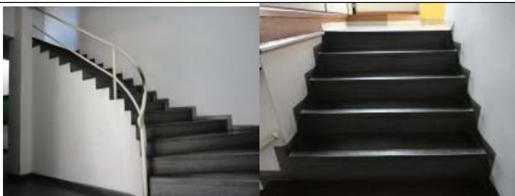
Fotos 31 e 32 – Escada de concreto revestida com piso vinílico. Localizada no fundo do bloco cuja testada dá para a Praça Carlos Gomes.
