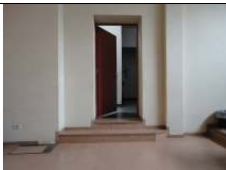
Fotos 37, 38 e 39 – Praça interna, com escada e rampa existentes, degraus em concreto no acesso e dentro do auditório.
