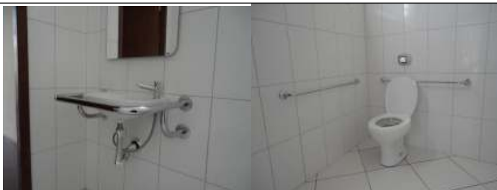
Fotos 42 e 43 – Instalação sanitária para pessoas com deficiência.
