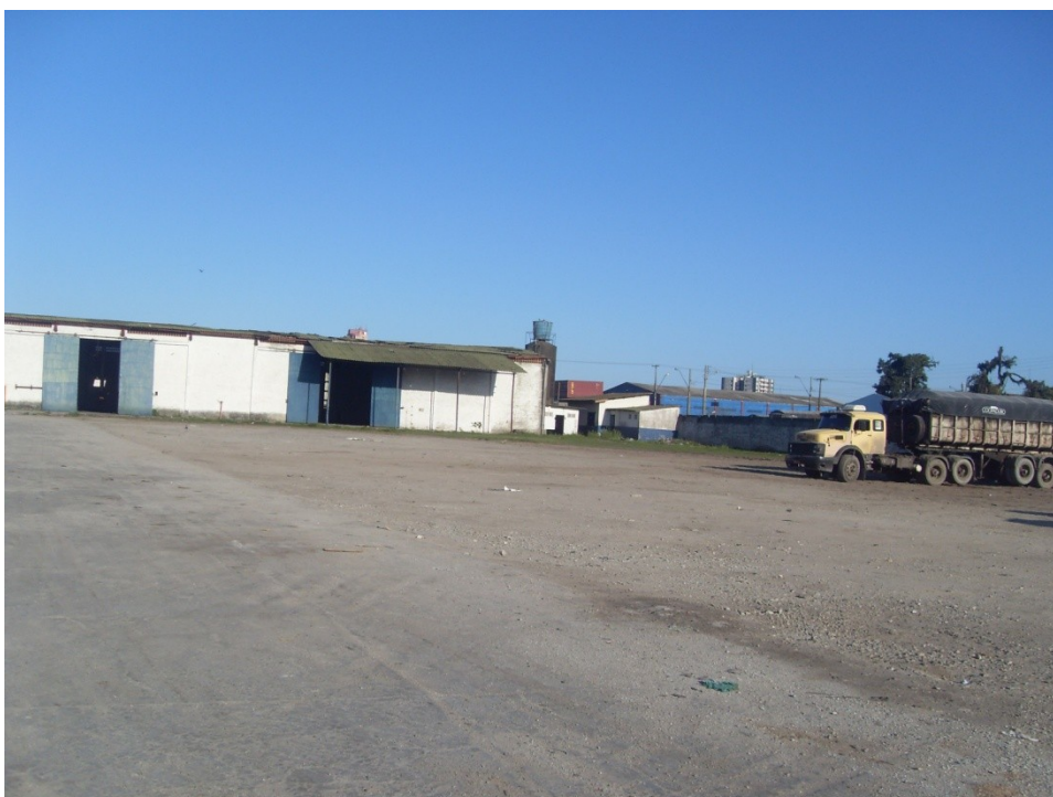
Figura 10 – Pátio de estacionamento da COOPADUBO
