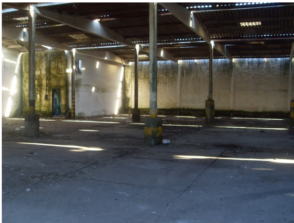
Figura 12 – Armazém abandonado dentro do pátio da COOPADUBO
