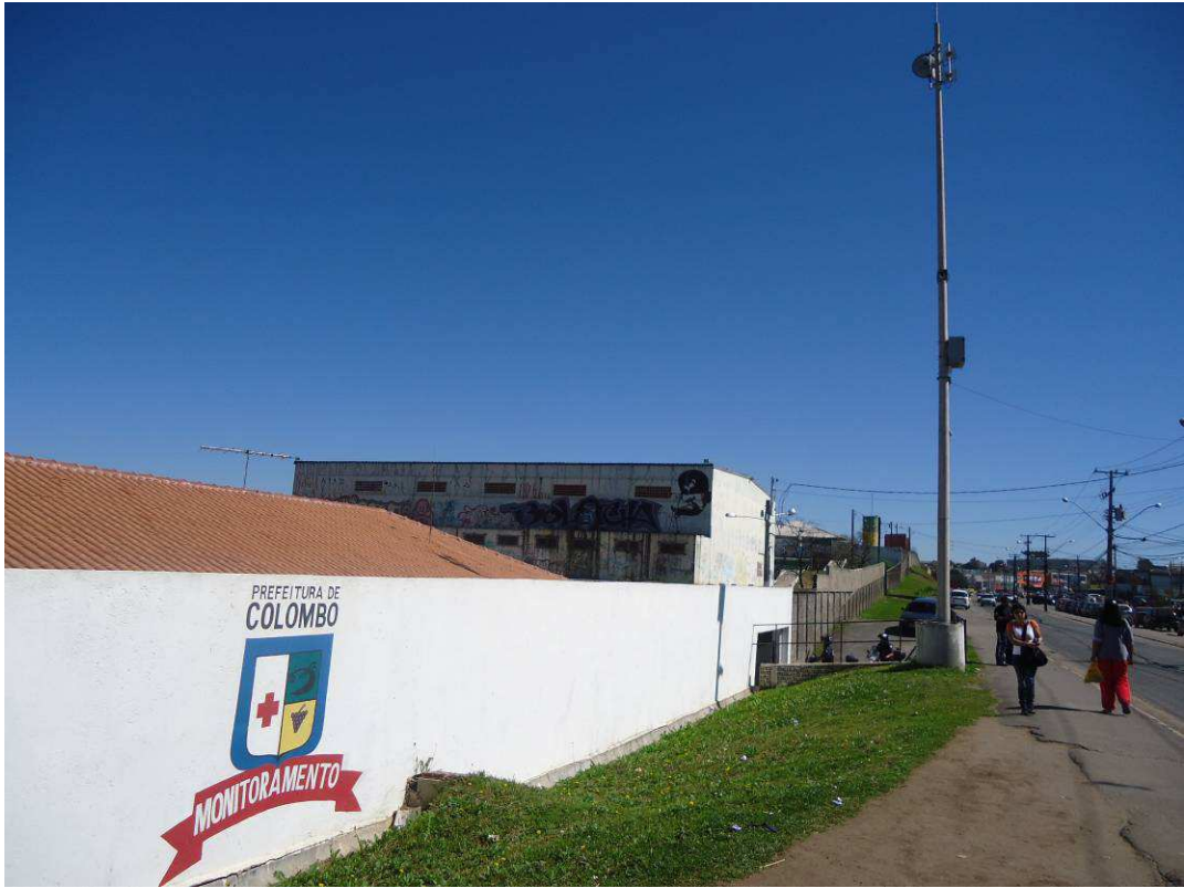
Centro de Controle de Operações
