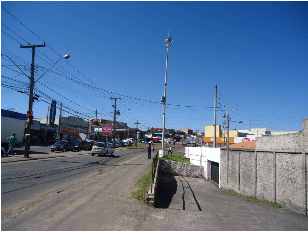
Centro de Controle de Operações (Receptora)
