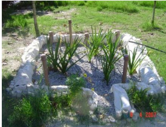
FIGURA 11 - ESTAÇÃO DE TRATAMENTO DE ESGOTO POR ZONA DE RAÍZES CONSTRUÍDA EM UMA CASA COM QUATRO MORADORES. VILA DAS PEÇAS, MARÇO DE 2007.
