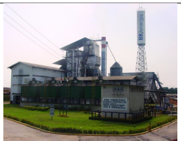
Foto 04 – Sede da empresa B.K. Energia Itacoatiara Ltda
