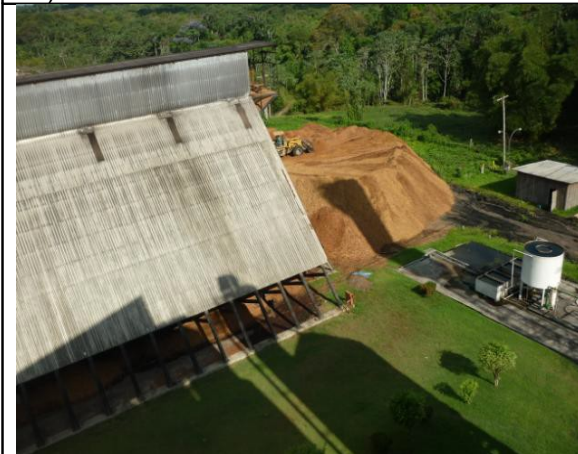
Foto 07 Silo de armazenagem dos resíduos -set/11
