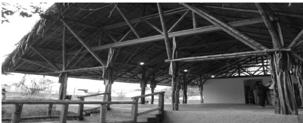
Figura 10 - Construção em bambu e madeira - Parque Ambiental em Sena Madureira. Fonte: Fotografado pelo autor (2011)
