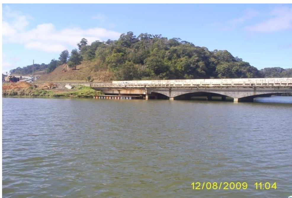
Foto 2 – Primeira ponte que cruza o reservatório. Local de coleta dos pontos denominados P2 e P3.
