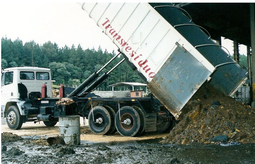
FIGURA 35 - SOLO CONTAMINADO DE BARRO PRETO NA FABRICA DE CIMENTO ITAMBÉ
