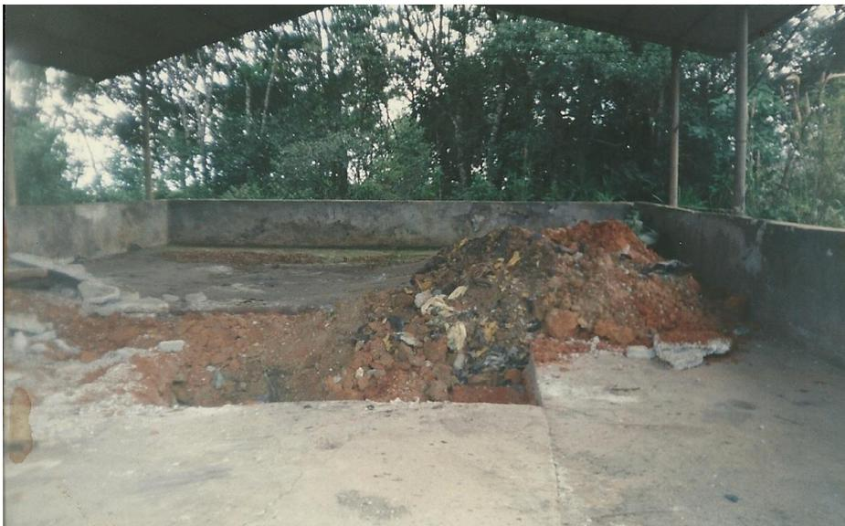
FIGURA 29 - MATERIAL ENTERRADO SOB O PISO DEMOLIDO NO BARRACÃO DO DEPÓSITO BARRO PRETO
