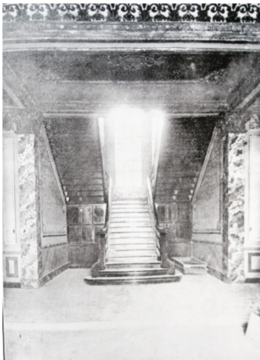
FIGURA 89 - OBRAS ESCOLA NORMAL ENTRADA PRINCIPAL FONTE: PARANÁ. 1926.
