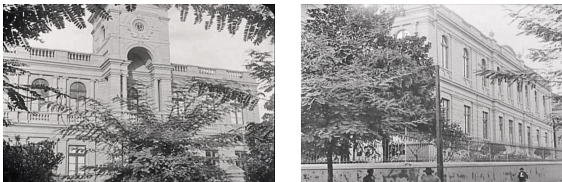
FIGURA 56 - CENAS DO EDIFÍCIO DO GINÁSIO PARANAENSE E ESCOLA NORMAL. FONTE: BOTELHO, "L'ETAT DU PARANÁ", ANO 1928.
