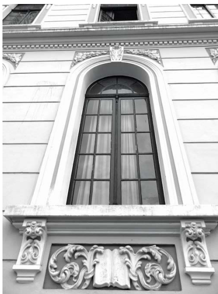
FIGURA 99 - DETALHE JANELA PAVIMENTO TÉRREO – ESCOLA NORMAL DE PARANAGUÁ, 2012. FONTE: ACERVO PESSOAL.
