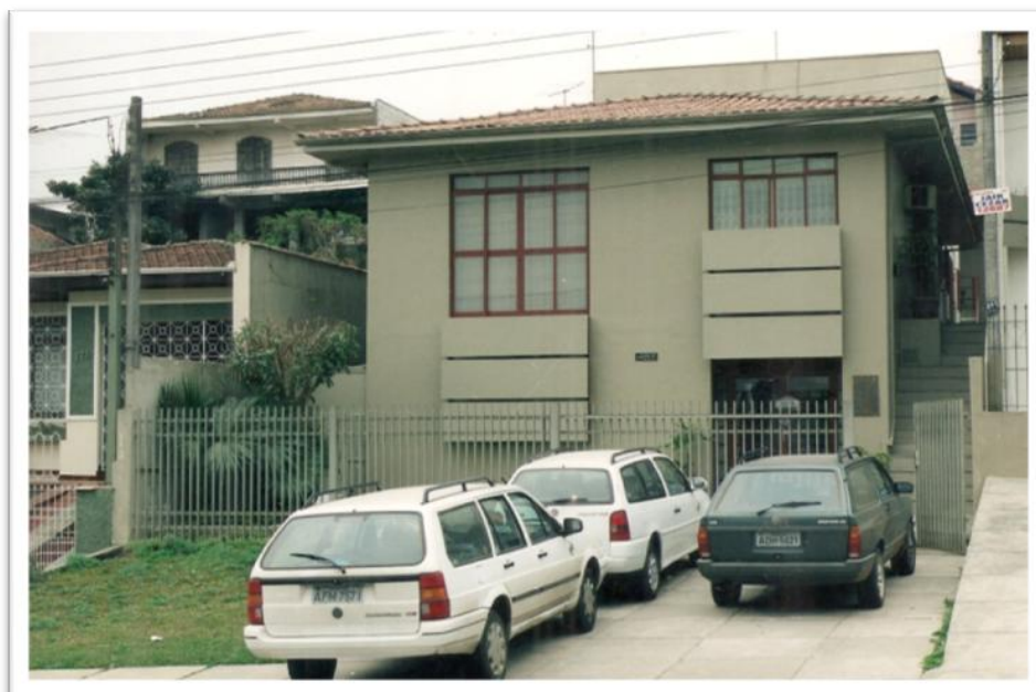
FIGURA 6 - EM 1991, CONCLUSÃO DAS REFORMAS NA SEDE LQL DO PARLPR DA APCBRH, CURITIBA-PR
