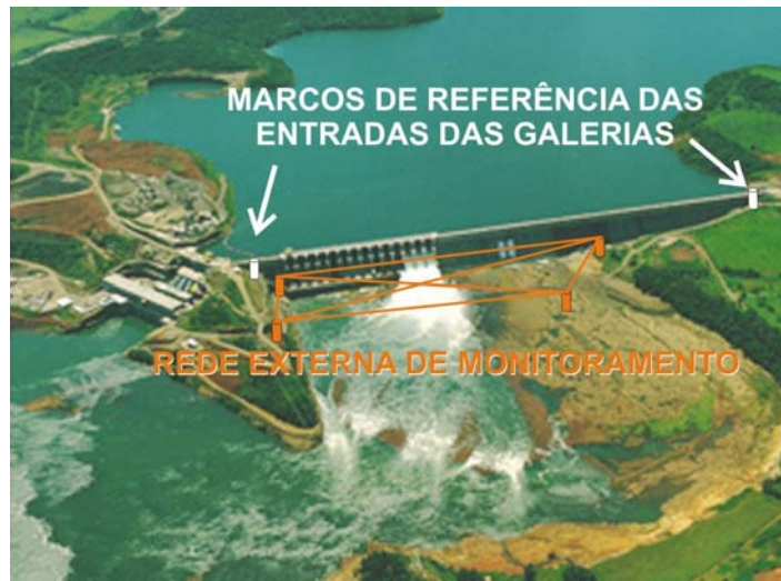
FIGURA 21 - REDEGEODÉSICA DE MONITORAMENTO EXTERNO
