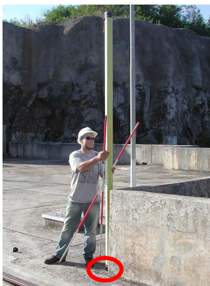
FIGURA 38 – RN 50A – MARGEM DIREITA DA BARRAGEM
