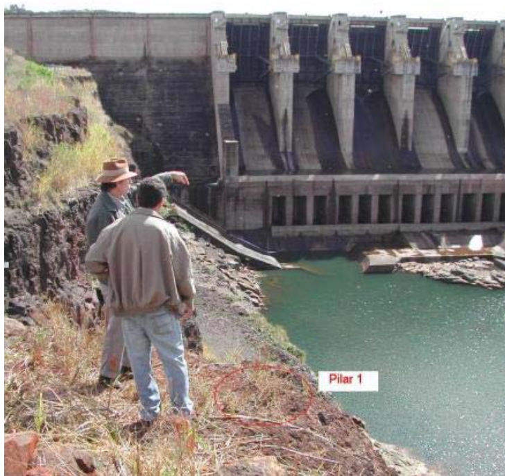
FIGURA 10. INDICAÇÃO DA POSIÇÃO DO PILAR 1
