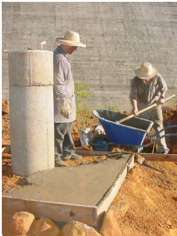
FIGURA 19 -CONSTRUÇÃO DO PILAR 4
