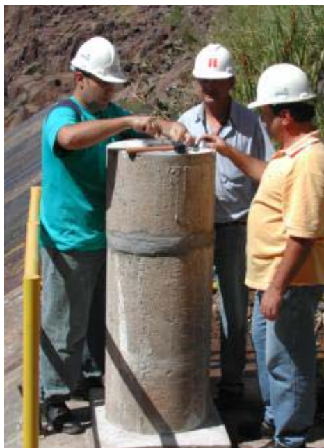
FIGURA 23 – INSTALAÇÃO DO SISTEMA DE CENTRAGEM FORÇADA
