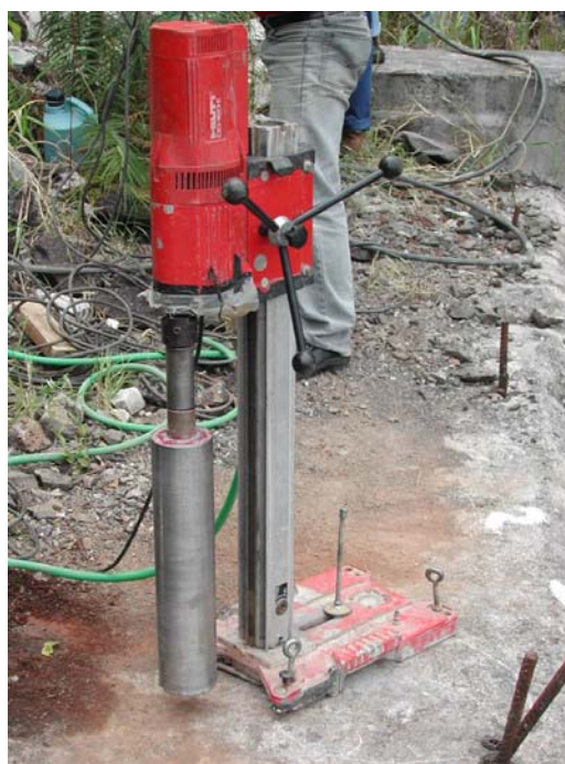
FIGURA 16 - PERFURATRIZ NO LOCAL DE IMPLANTAÇÃO DO PILAR 2
