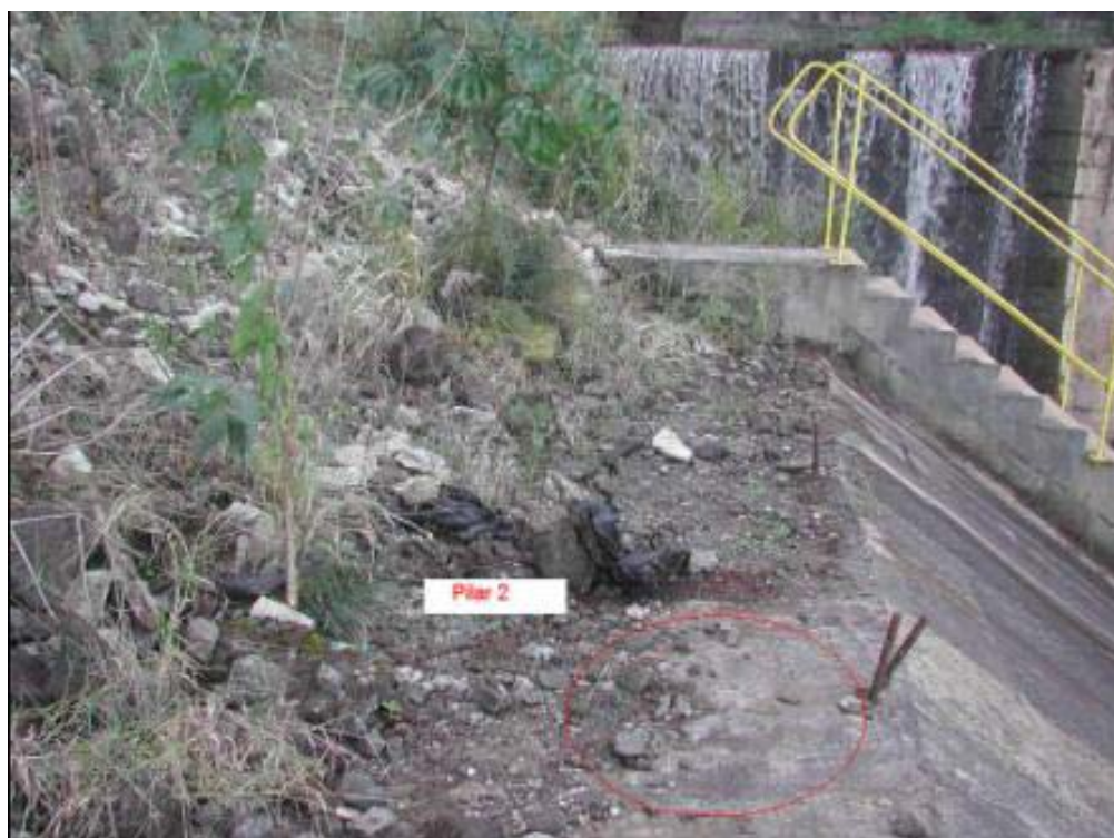
FIGURA 11. INDICAÇÃO DA POSIÇÃO DO PILAR 2
