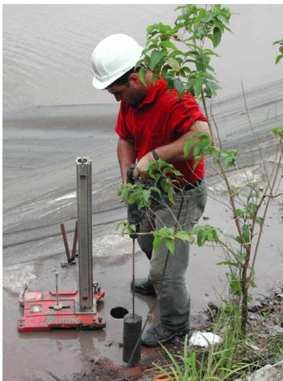
FIGURA 17 – PERFURAÇÃO PARA IMPLANTAÇÃO DO PILAR 2
