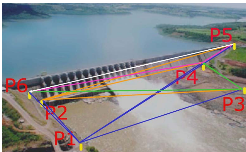
FIGURA 28 – CONFIGURAÇÃO DA REDE DE MONITORAMENTO EXTERNO (VISÃO PANORÂMICA)
