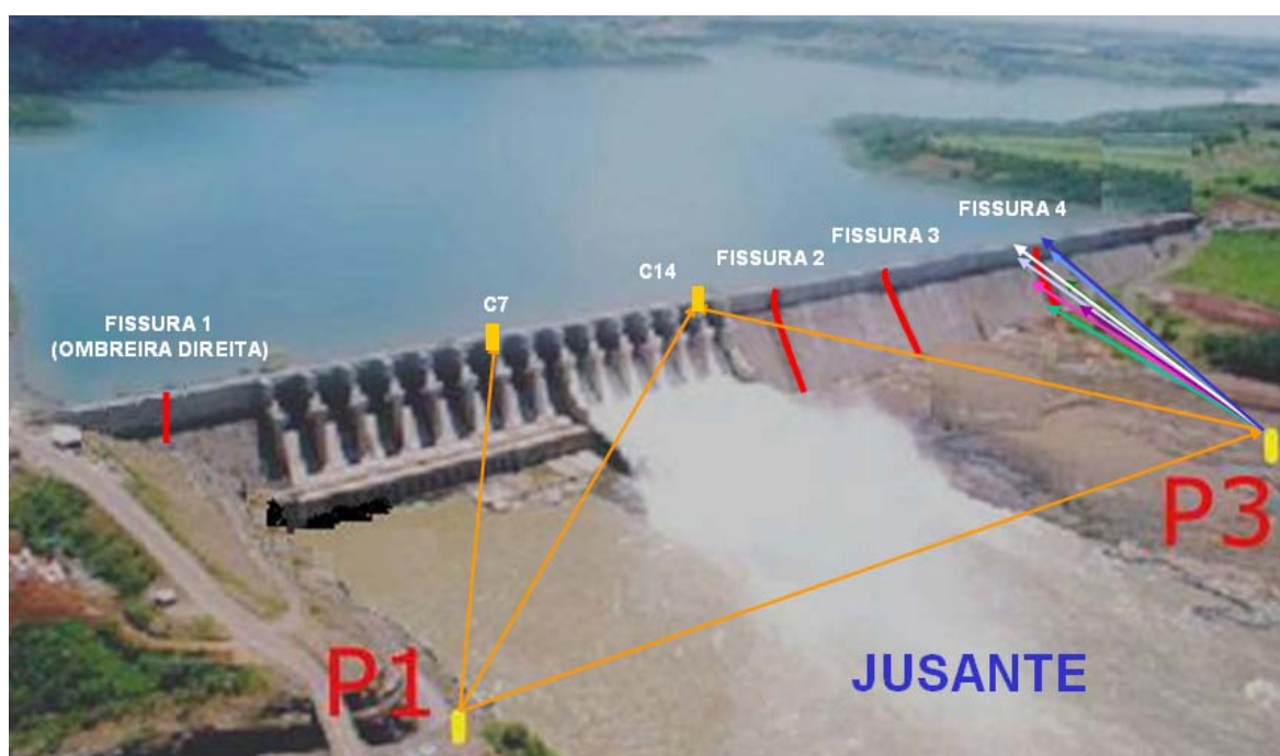
FIGURA 30 – MONITORAMENTO DAS FISSURAS DA BARRAGEM A PARTIR DOS PILARES P1 E P3.
