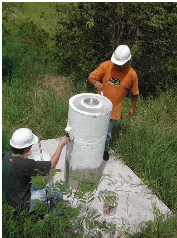
FIGURA 26 – PINTURA DOS PILARES
