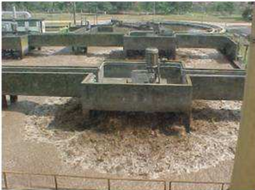
Figura 2.1: Tanques de Aeração ou Reatores Biológicos - REPAR.
