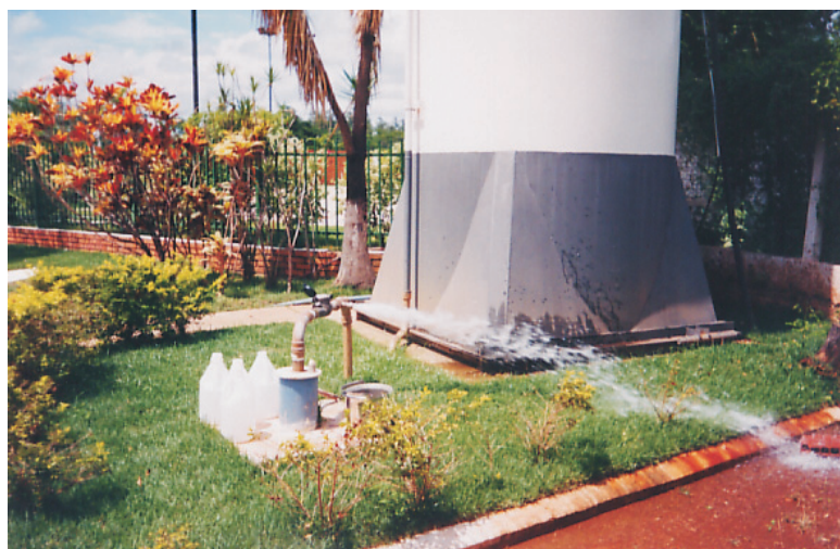
Foto 13 - Exemplo de poço adequado à Portaria 1291/2000MT.
