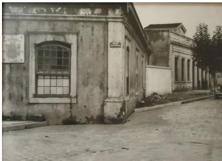
FIGURA 10 - CASA QUE ABRIGAVA A SOCIETÀ DANTE ALIGHIERI E SUA ESCOLA EM FRENTE À PRAÇA ZACARIAS – DÉCADA DE 1920
