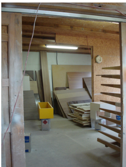
FIGURA 19 - SALA DE SECAGEM, DENTRO DO SETOR DE PINTURA
