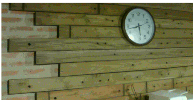
FIGURA 10 - PAINEL DE CRUZETA RECÉM TRATADA COM CCA NO INTERIOR DO ESCRITÓRIO DE UMA MADEIREIRA EM CURITIBA-PR
