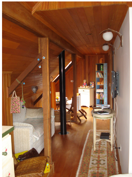
FIGURA 13 - SÓTÃO DE RESIDÊNCIA COM PISO, FORRO E ESTRUTURA TRATADOS COM STAIN IMPREGNANTE
