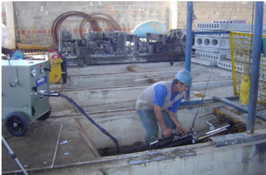
FIGURA 7 – FUNCIONÁRIO POSICIONANDO O MACACO QUE PROTENDE CADA CORDOALHA ISOLADAMENTE. FONTE: PETRUCELLI (2009).
