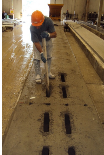
FIGURA 3 – EXECUÇÃO DE ABERTURA DOS ALVÉOLOS NA FÁBRICA PARA POSTERIOR CONCRETAGEM NA OBRA.
