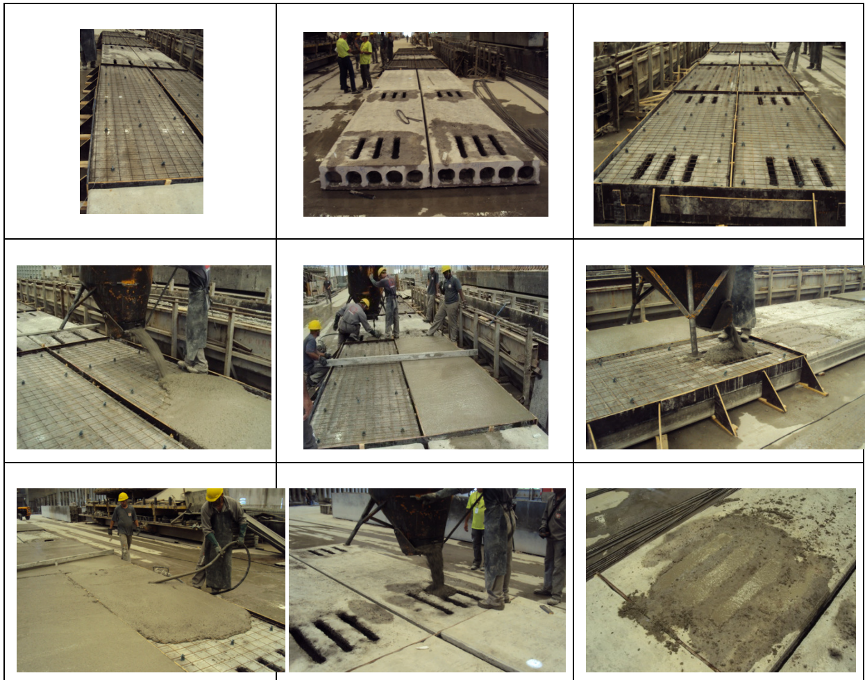
FIGURA 27 – CONCRETAGEM DOS ALVÉOLOS E DA CAPA DAS LAJES. FONTE: A autora (2011).
