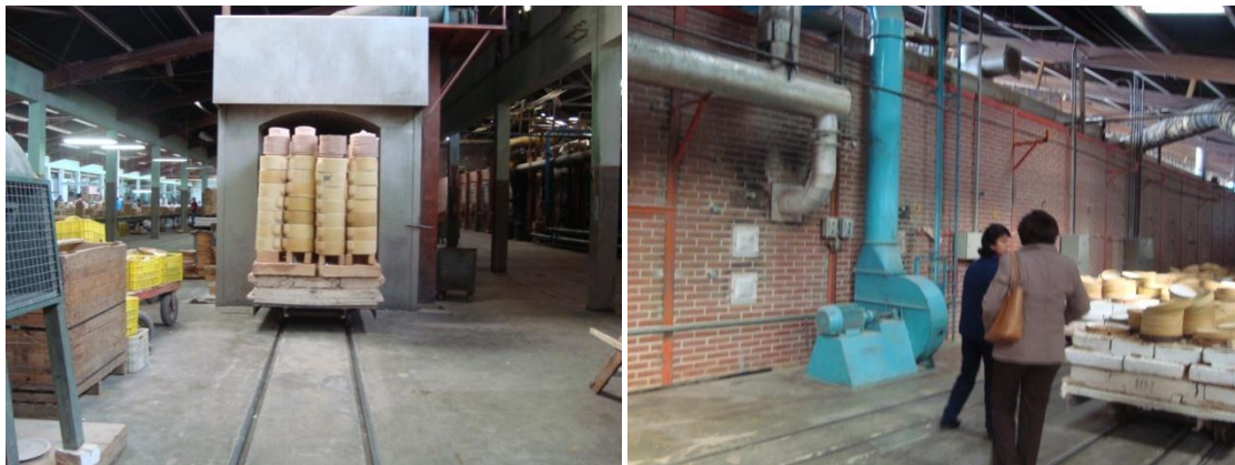
Figura 41 - Entrada e lateral do forno da empresa Schmidt FONTE: A autora (2011)
