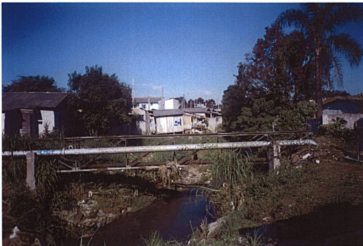
FOTO Nº.12 – OCUPAÇÃO IRREGULAR VILA REX – XAXIM
