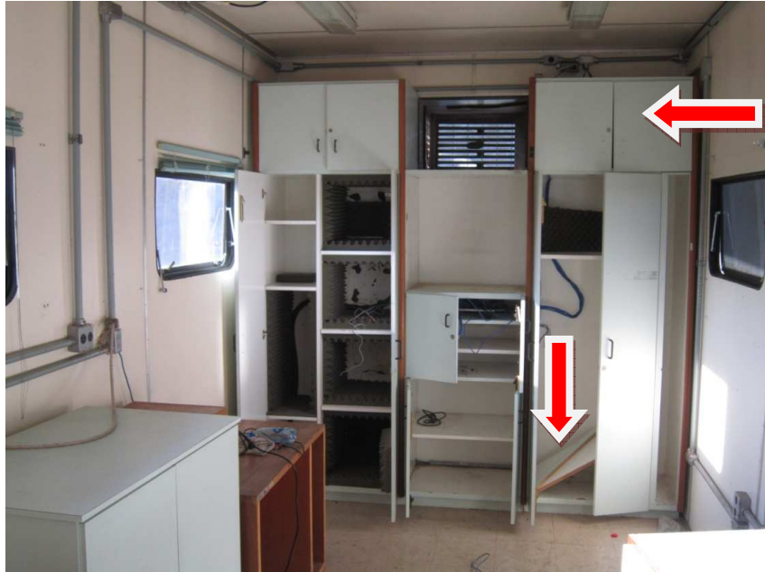
Figura 65: Portas desalinhadas e prateleira caída. Fonte: Matheus (2011)
