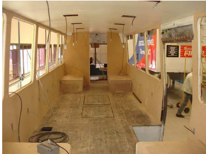
Figura 42: Plugues e conexões na instalação elétrica. Fonte: Jardim (2010).
