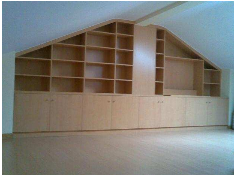
Figura 37: Armários e prateleiras feitos sob o vão do telhado. Fonte: Wood Factory (2010)
