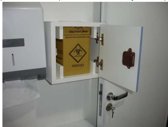
Figura 4: Pequeno armário com dobradiças tipo caneca
