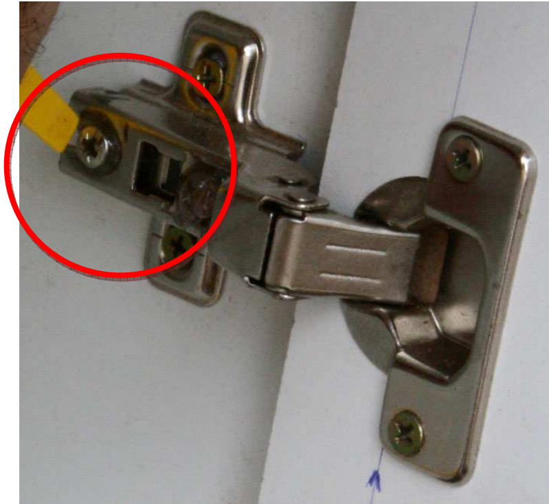
Figura 90: Aplicação de adesivo epoxi nos parafusos das dobradiças
