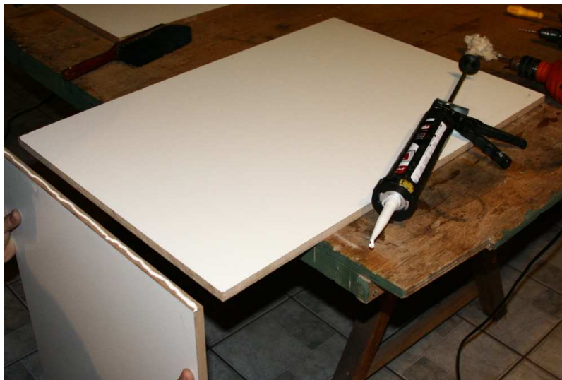
Figura 89: Aplicação de adesivo nos painéis estruturais
