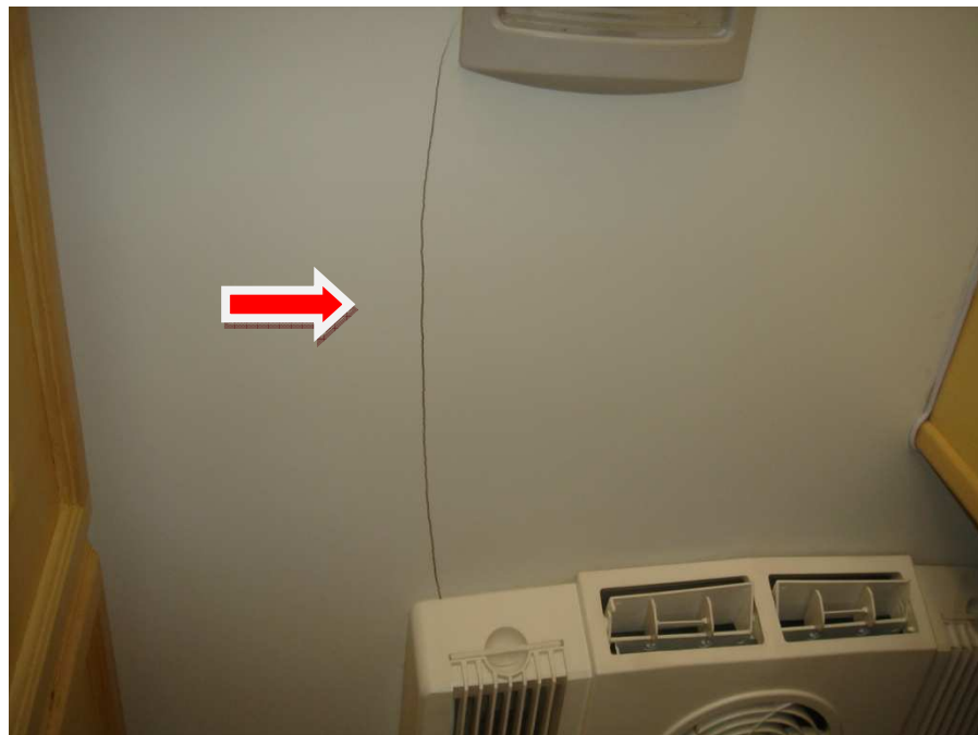
Figura 62: Rachadura em teto de motorhome. Fonte: Matheus (2011)
