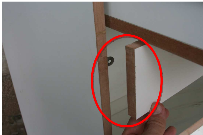
Figura 107: Lado esquerdo da testeira solto
