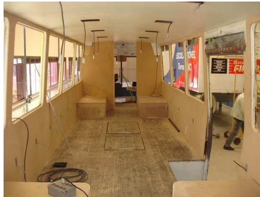
Figura 3: Interior de escola de informática móvel em construção
