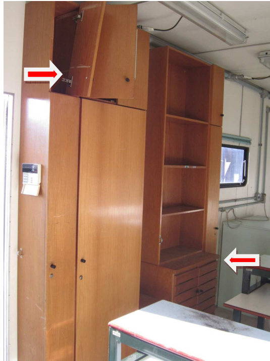
Figura 67: Dobradiças quebradas e portas soltas. Fonte: Matheus (2011)
