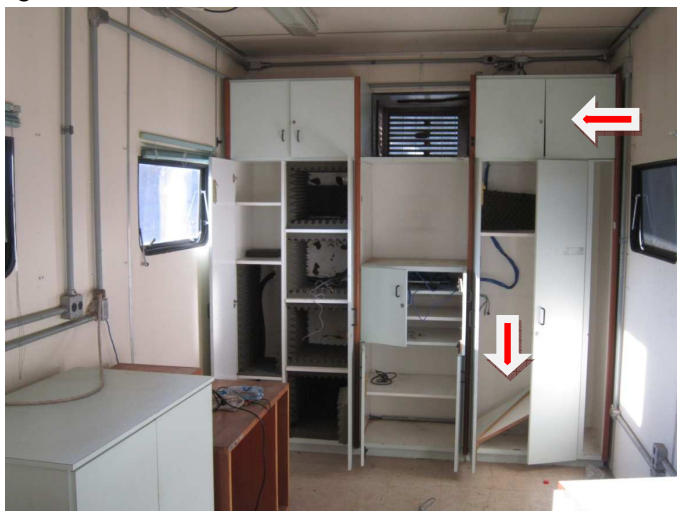
Figura 8: Portas desalinhadas e prateleira caída.
