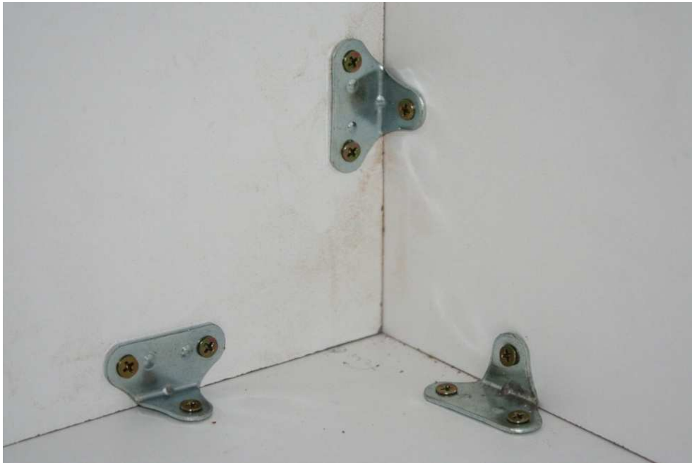
Figura 85: Fixação interna dos painéis estruturais
