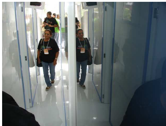
Figura 2: Piso sem emendas feito com resina epoxi
