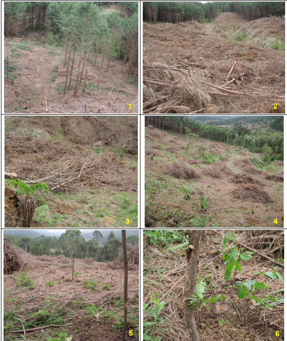
Figura 3.12. Execução do PRAD em APP. (1 e 2) Supressão das espécies exóticas situadas em APP's; (3) Transposição do resíduo em curvas de nível para contenção da água da chuva evitando o processo erosivo e possibilitando a recuperação da área. (4) Limpeza do resíduo florestal através da implantação da técnica "transposição de galhadas" para facilitar a recuperação com plantio de nativas. (5) Alinhamento, identificação e Plantio de Nativas; (6) Plantio de Nativas – Aroeira - Schinus terebinthifolius . Fonte: PRAD – Comfloresta, 2008.
