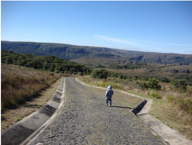
Foto 5: Estrada pavimentada com cantaria em Diabásio. Autora: HORNES, 2010.
