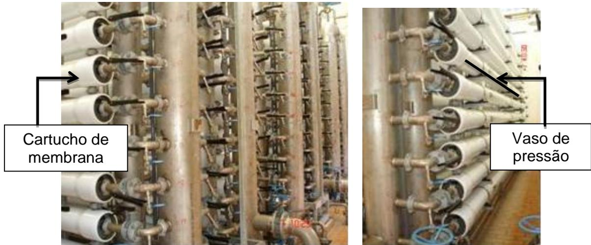
FIGURA 9 – DETALHES DA PLANTA DE ULTRAFILTRAÇÃO
