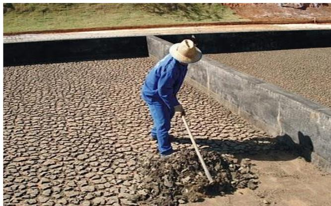
FIGURA 10 - Etapa de retirada do lodo de esgoto numa ETE após a fase de decantação e secagem.
