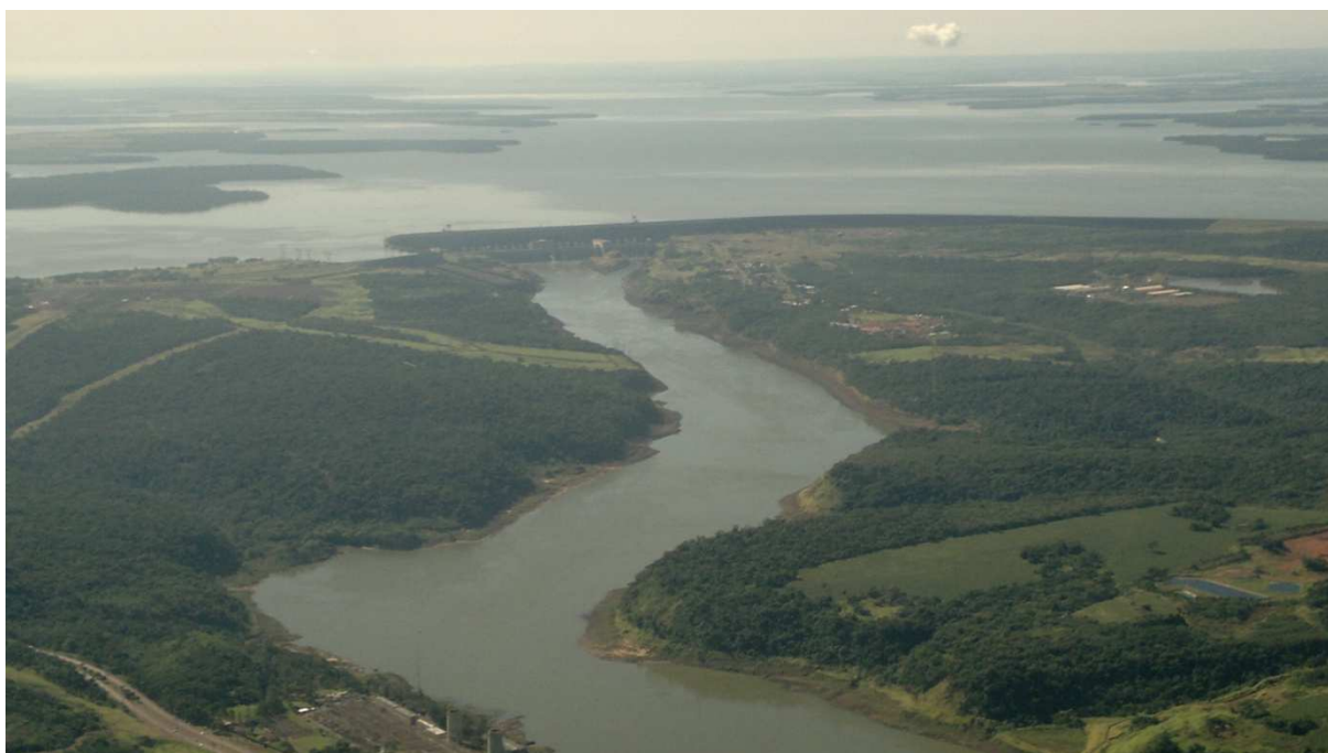
FIGURA 1 - FOTOGRAFIA AÉREA DA USINA HIDRELÉTRICA DE ITAIPU. À direita da foto localiza-se a margem brasileira e à esquerda a margem paraguaia do rio Paraná FONTE: O autor (2011)
