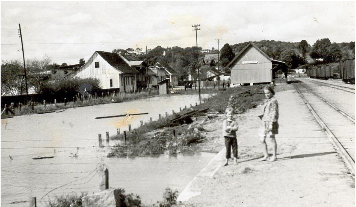
FIGURA 76 - Antigo centro de Guajuvira: estação trem à direita FONTE: Arquivo Municipal
