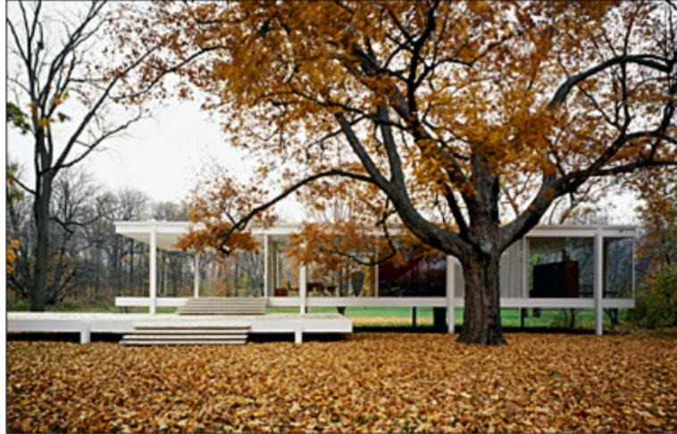
FIGURA 2.2 - FARNSWORTH HOUSE (1951, CHICAGO IL, EUA) FONTE: Farnsworth House Foundation (2010)
