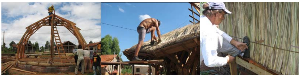
FIGURA 4.7 - ETAPAS DE CONSTRUÇÃO DA CASA TATU (TEMA DA TURMA 2005/1) PROJETO PROPOSTO PELO ENTÃO ACADÊMICO OLIVER HEIZMANN FONTE: Blog P7 Sustentável (2011)
