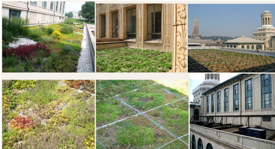
FIGURA 2.5 - COBERTURAS VERDES EM EDIFÍCIOS DO CAMPUS DA UNIVERSIDADE CARNEGIE MELLON
