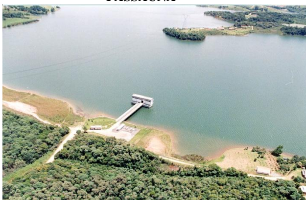
FIGURA 31 - VISTA AÉREA DO RESERVATÓRIO PASSAÚNA
