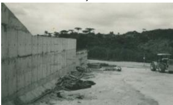
FIGURA 27 - CONSTRUÇÃO DA BARRAGEM
