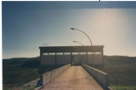
FIGURA 26 - TORRE DE CAPTAÇÃO
