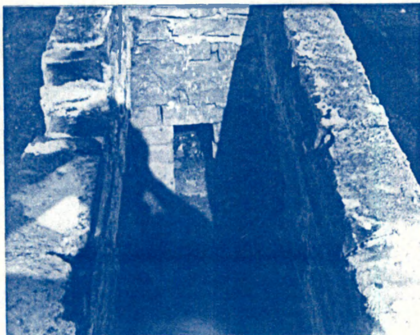
FOTO 18 - PARAPEITO DE TIJOLOS
