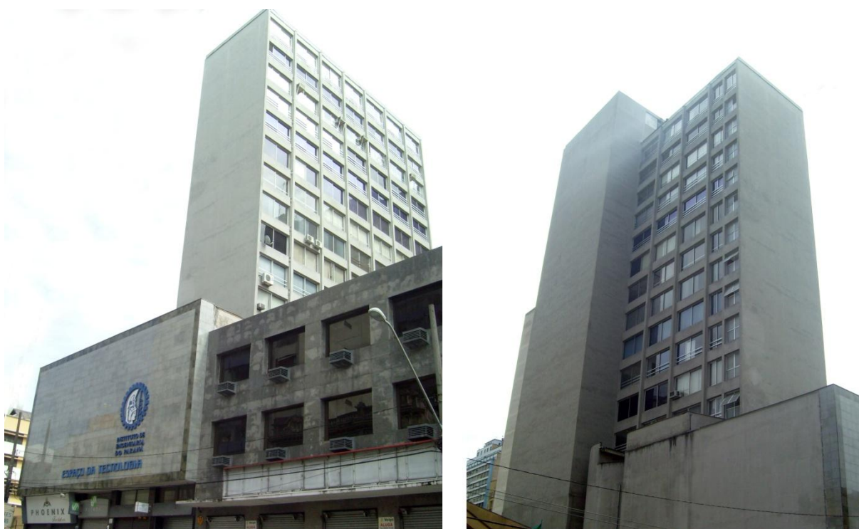
Figura 7.3 - Vista da fachada nordeste e sudoeste do edifício.
