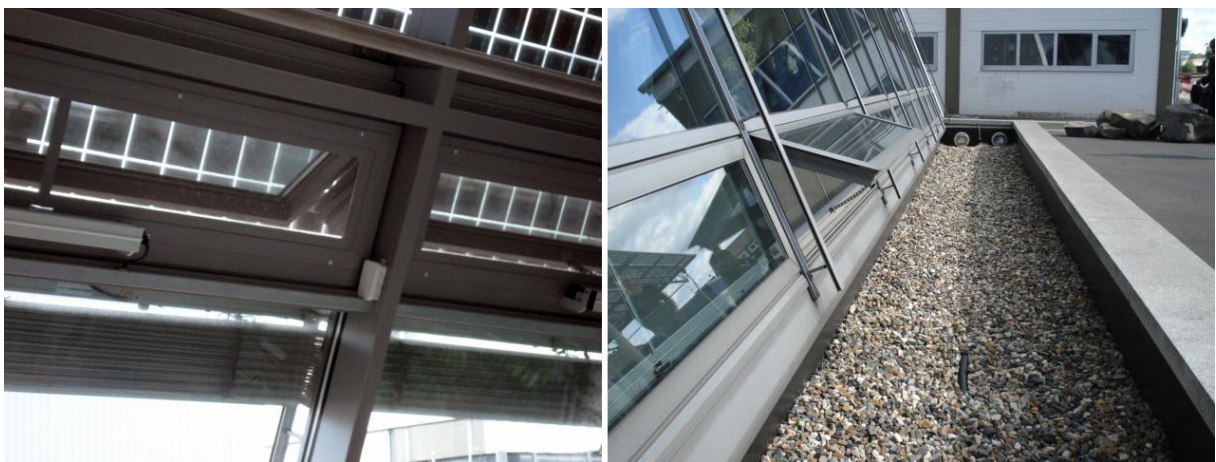
Figura 7.10 - Fachada dupla ventilada do edifício SME, em Kassel, Alemanha. FONTE: Aloísio Leoni Schmid, 2011.
