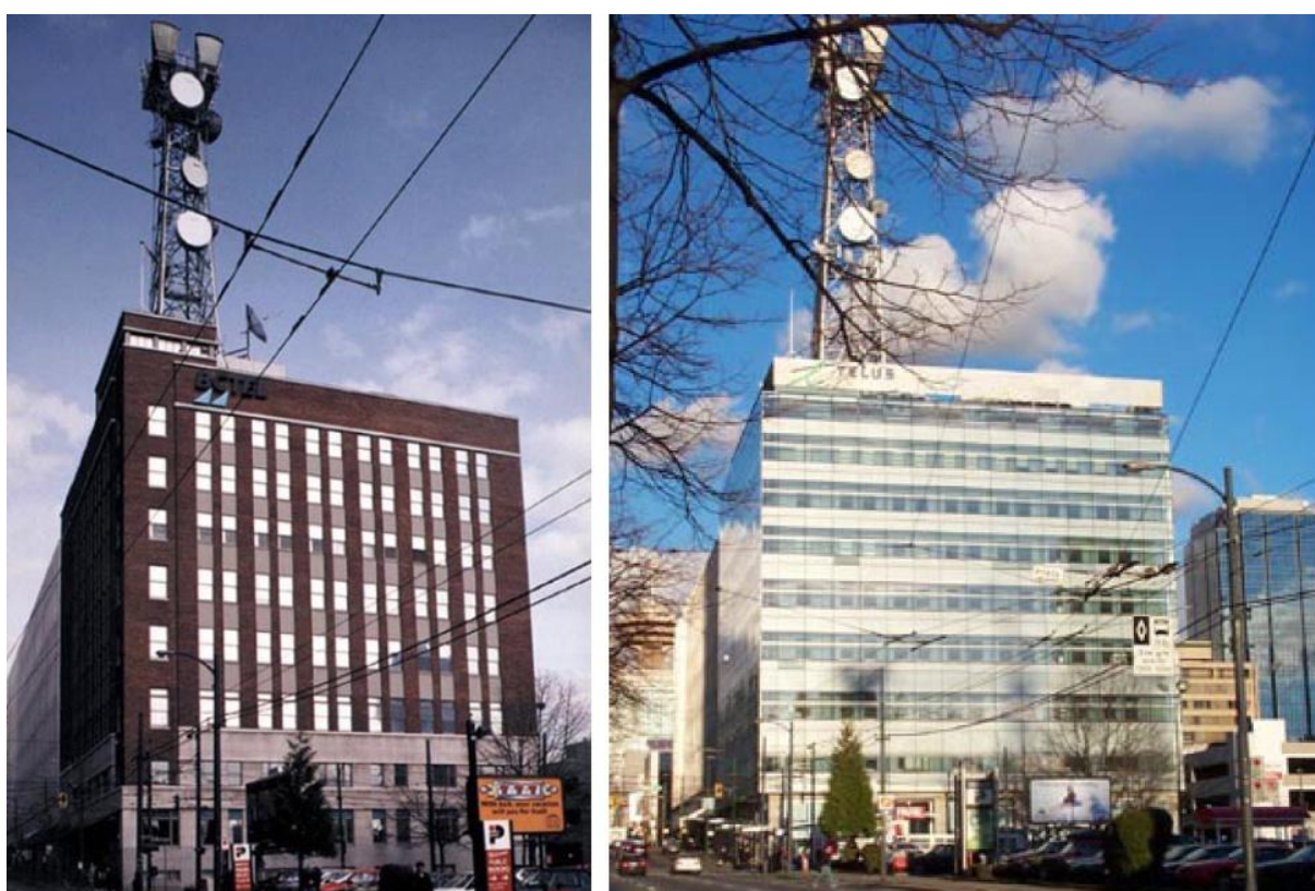
Figura 2.7. Telus Building - antes e depois da renovação. FONTE: MEYER-BOAKE, 2003
