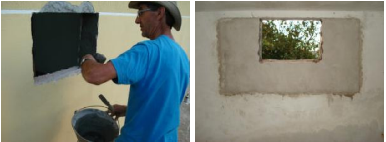
Requadramento da abertura para instalação do protótipo
