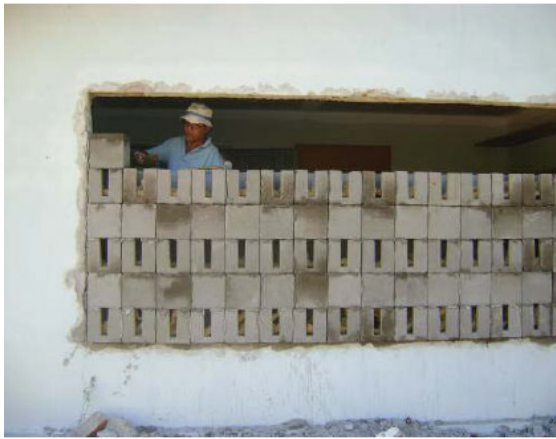
Bloco tipo 3 sendo montado com lâ de vidro
