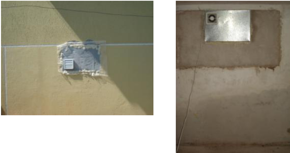
Vista externa do protótipo instalado – sem reboco Vista interna do protótipo instalado FIGURA 59 – Medição do nível de pressão sonora na fachada da câmara de testes – medição 6
