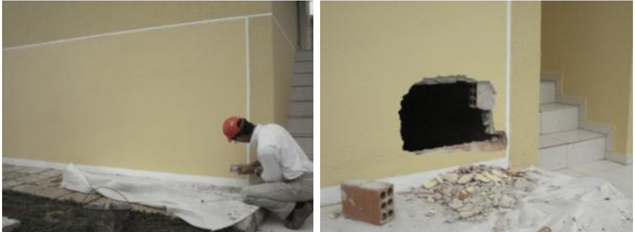
Abertura de acesso sendo executada
