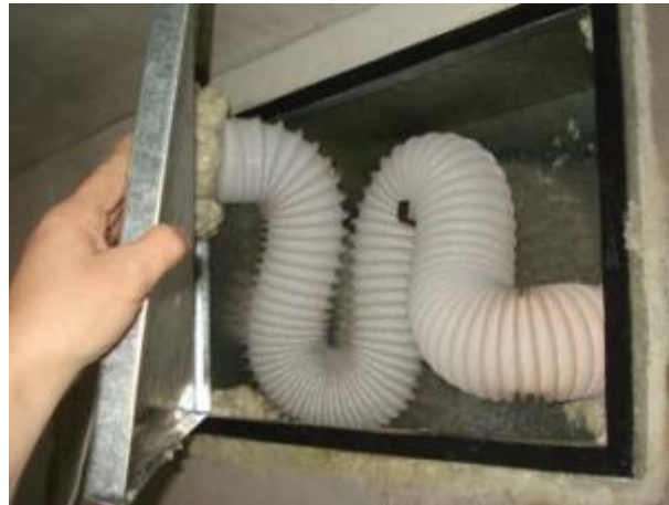
FIGURA 61 – Posicionamento da tubulação T1 para medição 6 (PR1) e 7 (PR2)
