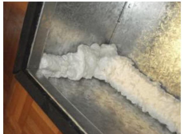
Detalhe da vedação dos cantos internos
