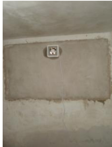
Abertura para instalação do renovador de ar RA1 Renovador de ar RA1 instalado FIGURA 56 – Medição do nível de pressão sonora na fachada da câmara de testes – medição 3 e 4
