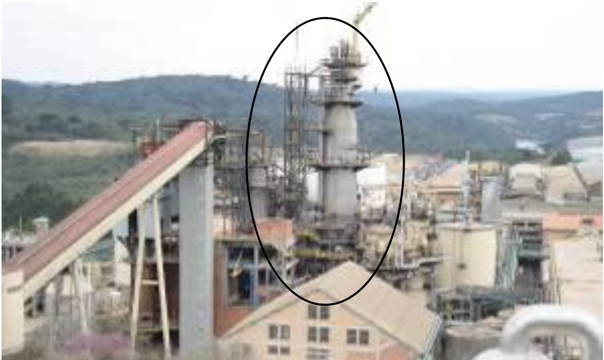
FIGURA 31 – DIGESTOR DE CONTÍNUO FONTE: O autor (2010)
