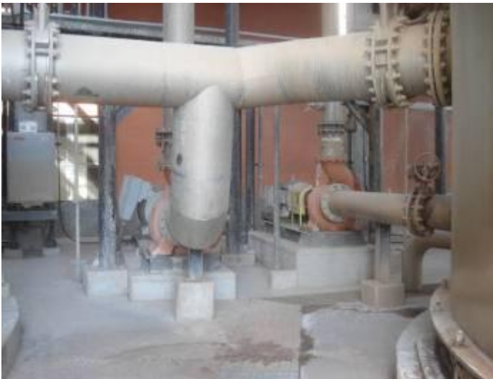
FIGURA 43 – PREPARO DE MASSA FONTE: O autor (2010)
