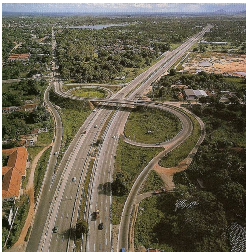
FIGURA 2.8: TRECHO DA RODOVIA BR-116 EM FORTALEZA-CE
