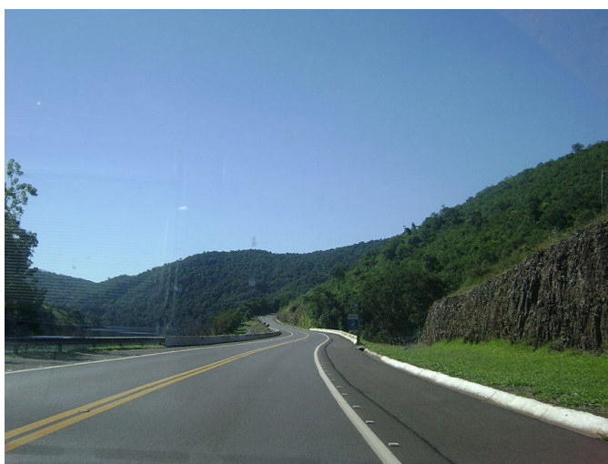
FIGURA 2.12: TRECHO DA RODOVIA BR-116 EM SANTA CATARINA, PRÓXIMO À DIVISA COM O RIO GRANDE DO SUL
