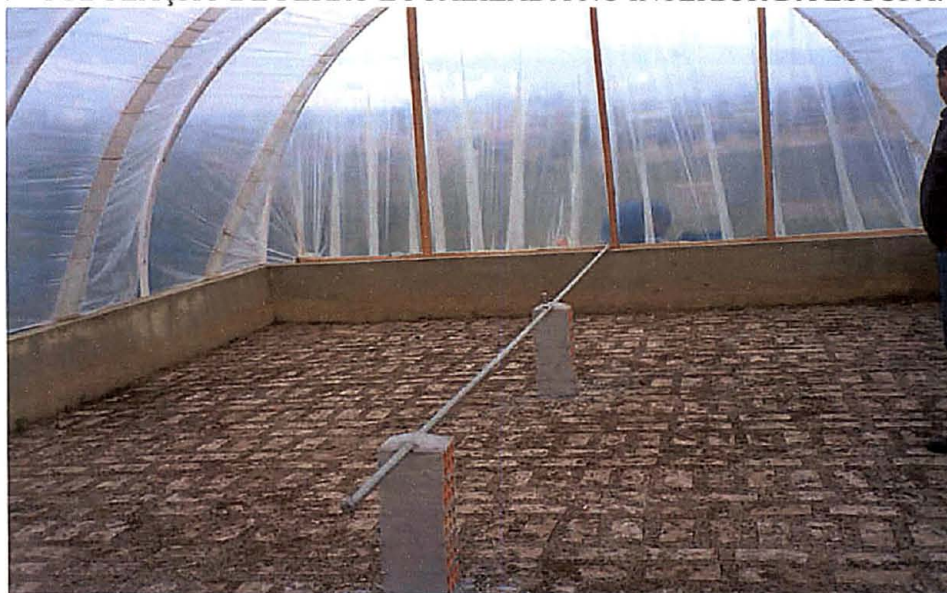
FIGURA 17 - TUBULAÇÃO DE FERRO LOCALIZADA NO INTERIOR DA ESTUFA.
