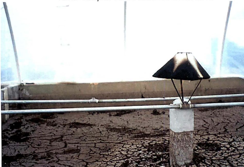
FIGURA 18 – CAPELA DE FERRO COLOCADA SOBRE A CHAMA PARA EVITAR DANIFICAÇÃO NA ESTRUTURA PLÁSTICA.
