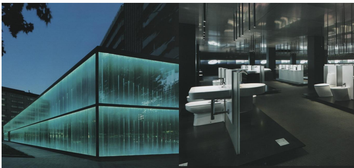
FIGURA 48 - PRÉDIO DA ROCA BARCELONA GALLERY FONTE - REVISTA TOP ROCA PROFISSIONAL, Nº 07 (2009, p. 12 e 14)
