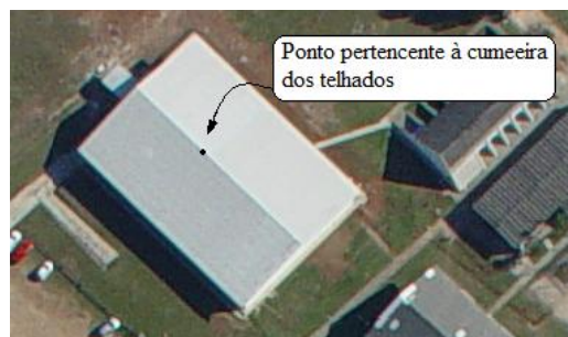
FIGURA 11 – PONTO CONTIDO NA CUMEEIRA DO TELHADO
