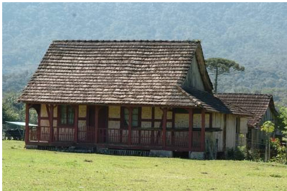
FIGURA 13 – CASA EM TÉCNICA ENXAIMEL, ARQUITETURA TÍPICA DA REGIÃO. FONTE: Arquivo PROMOTUR
