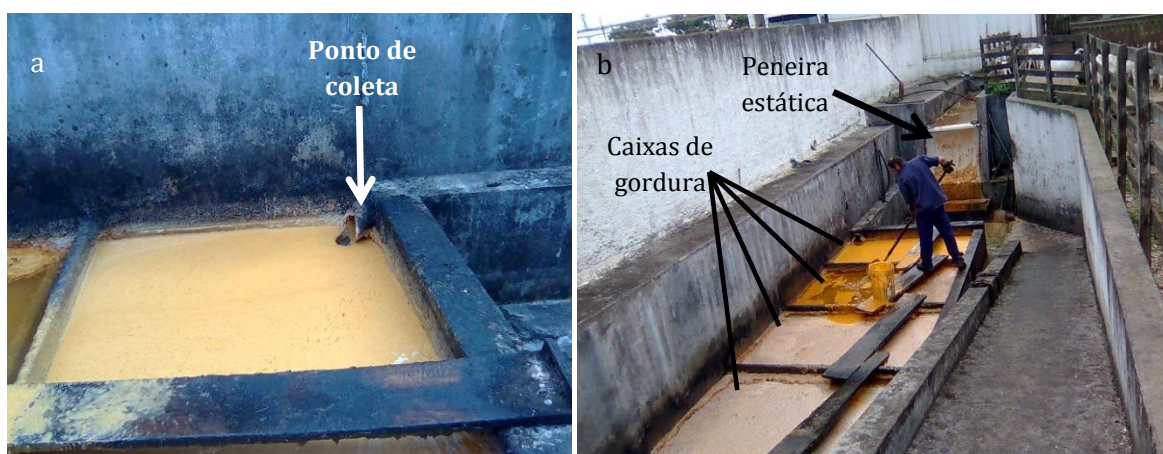
Figura 17. Coleta do efluente no sistema preliminar de tratamento da indústria frigorífica. a) Detalhe do ponto em que foi realizada a coleta do efluente. b) Vista geral do tratamento preliminar. Detalhe para o funcionário que executa a retirada da gordura flotada em média cinco vezes ao dia.
