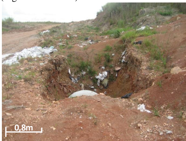
Figura 110: Resíduo aparente – exposto durante instalação de tubulação para drenagem (ERBE, 2010).
