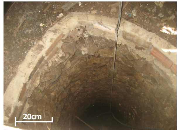
Figura 41: Poço situado a 300m ao Sul do depósito - água utilizada para o consumo humano (ERBE, 2010).
