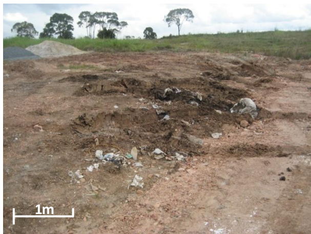
Figura 112: Resíduo aparente – exposto quando do início do projeto de execução de drenagem (ERBE, 2010).
