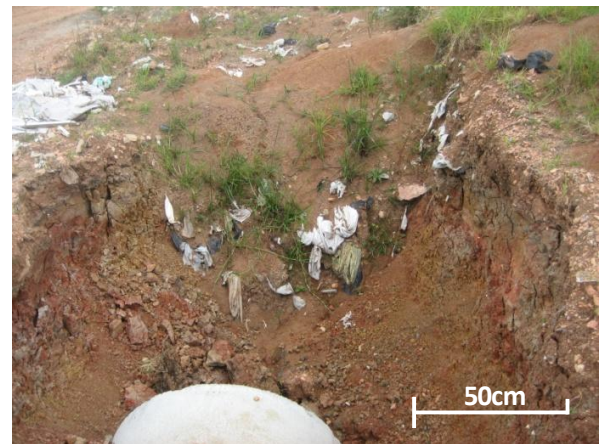
Figura 38: Resíduo aparente durante a implantação da tubulação (ERBE, 2010).
