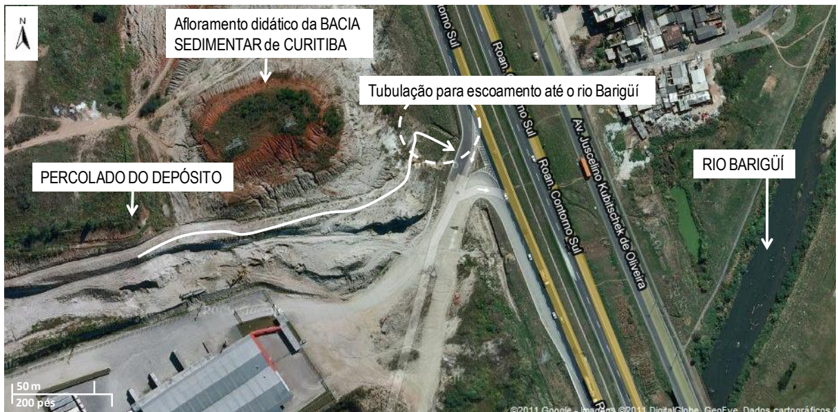
Figura 42: Caminho do percolado do depósito até o rio Barigüí (GOOGLE, 2011).
