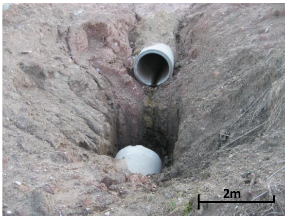
Figura 37: Captação de água através de tubulação (ERBE, 2010).
