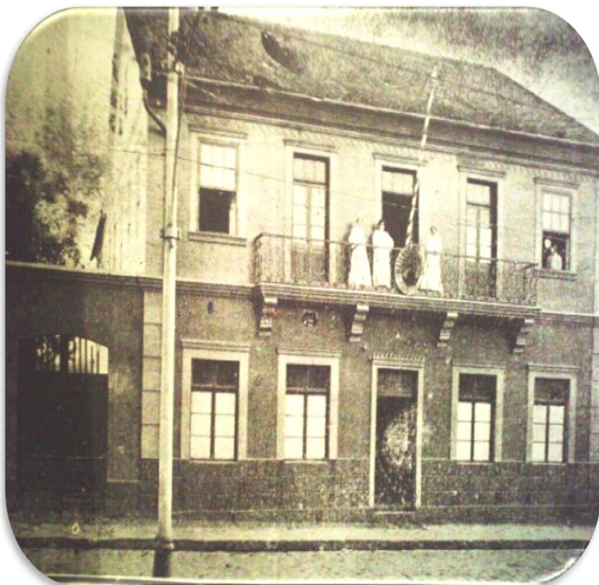
Figura 30 – Maternidade do Paraná, à Rua Comendador Araújo, n. 42, instalada em antigo edifício da Universidade do Paraná (1912). Fonte: Revista Médica do Paraná , Curitiba, ano 9, n. 11/12, [n. p.], nov./dez. 1940.
