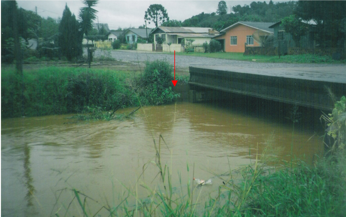
FIGURA 09 – RETIRADA DE SOLO EM PONTE NO BAIRRO SAGRADA FAMÍLIA
