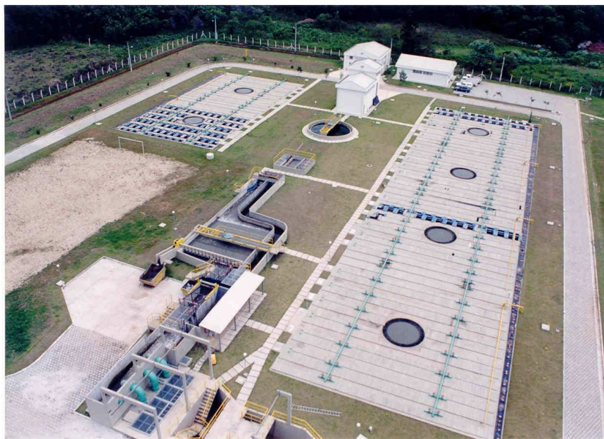
FIGURA 4.1 – VISTA DA ETE A FONTE: SANEPAR (1999).
